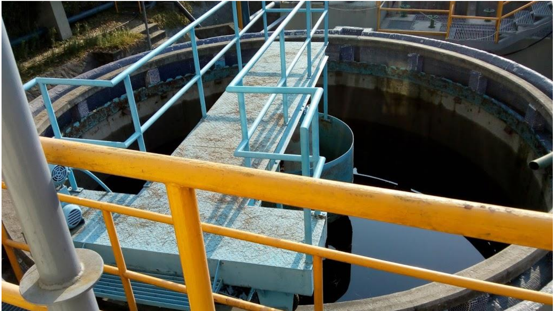
Figura A-10. Almacenamiento de agua residual tratada en PTAR de Ciudad Universitaria (antes utilizado como sedimentador).
