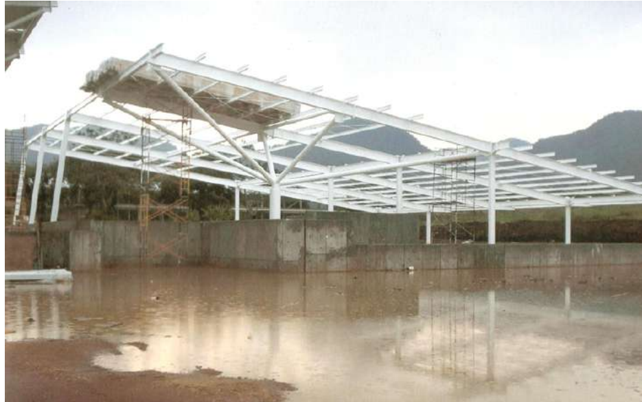
FIGURA 2.8: Fotografía de las primeras etapas de construcción de la biblioteca del campus USBI-Ixtac donde se puede apreciar las inundaciones de la zona.
