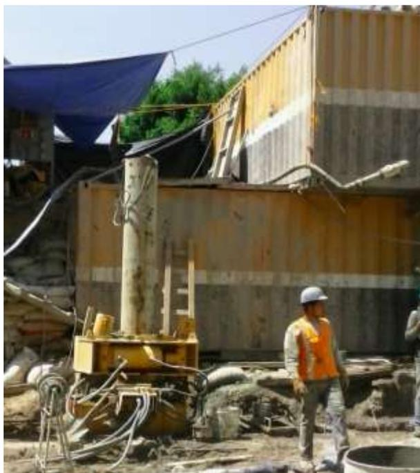
*Planta de fabricación de lodos fotografía 2.6*
