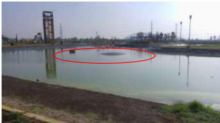
Figura 6. Fotografía del lago artificial del Parque Ecológico Cuitláhuac, en la cual se pueden observar las burbujas de gas que se formaron debajo de la geomembrana que cubre el lago (círculo rojo).
