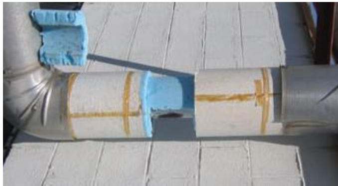
Figura 20 Inspección visual en tuberías (ASME, 2010)
