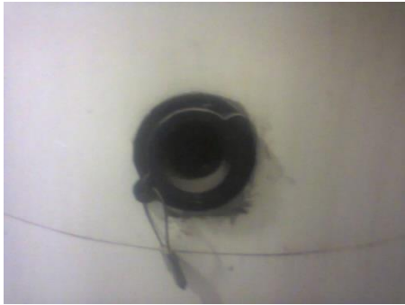
Figura 36 Tapón en punto de prueba para un recipiente aislado (Fotografía de campo)
