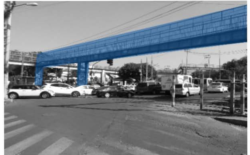
Imagen 47. Condiciones de Puente Peatonal.
