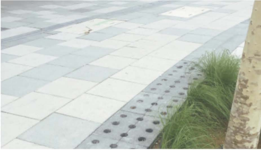
Imagen 180 . Tipología de acabado para piso
