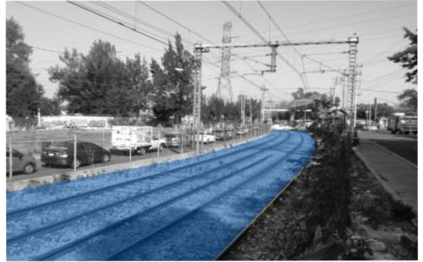
Imagen 45. Condiciones de Vías del Tren Ligero
