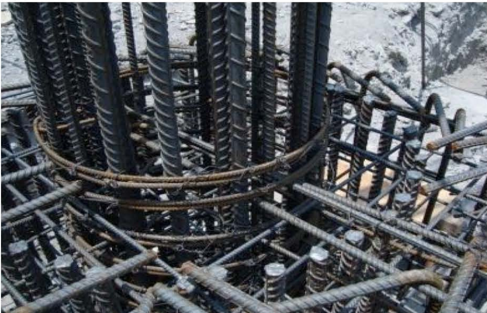
Imagen 158. Unión vigas de acero con concreto
