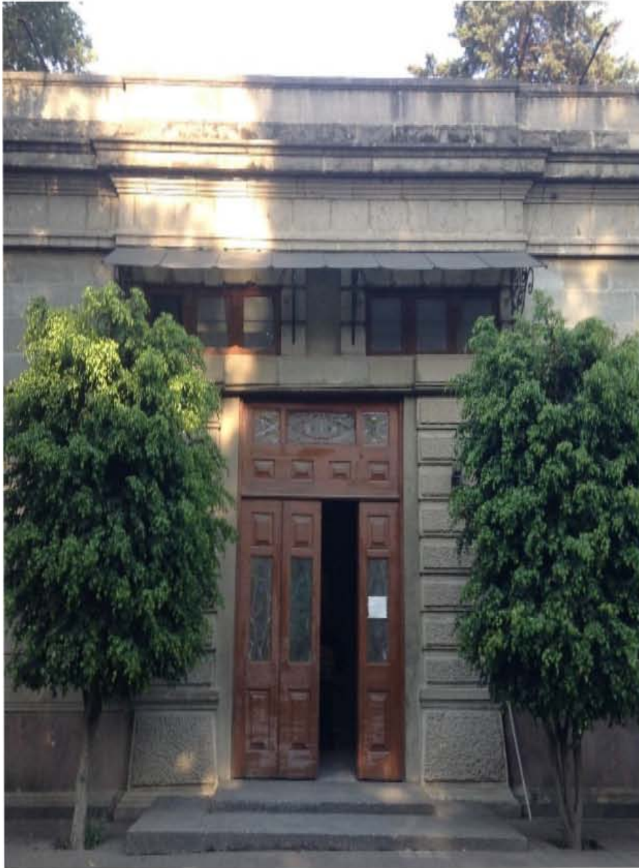
Imagen 19. Acceso del Centro Cultural Carlos Pellicer
