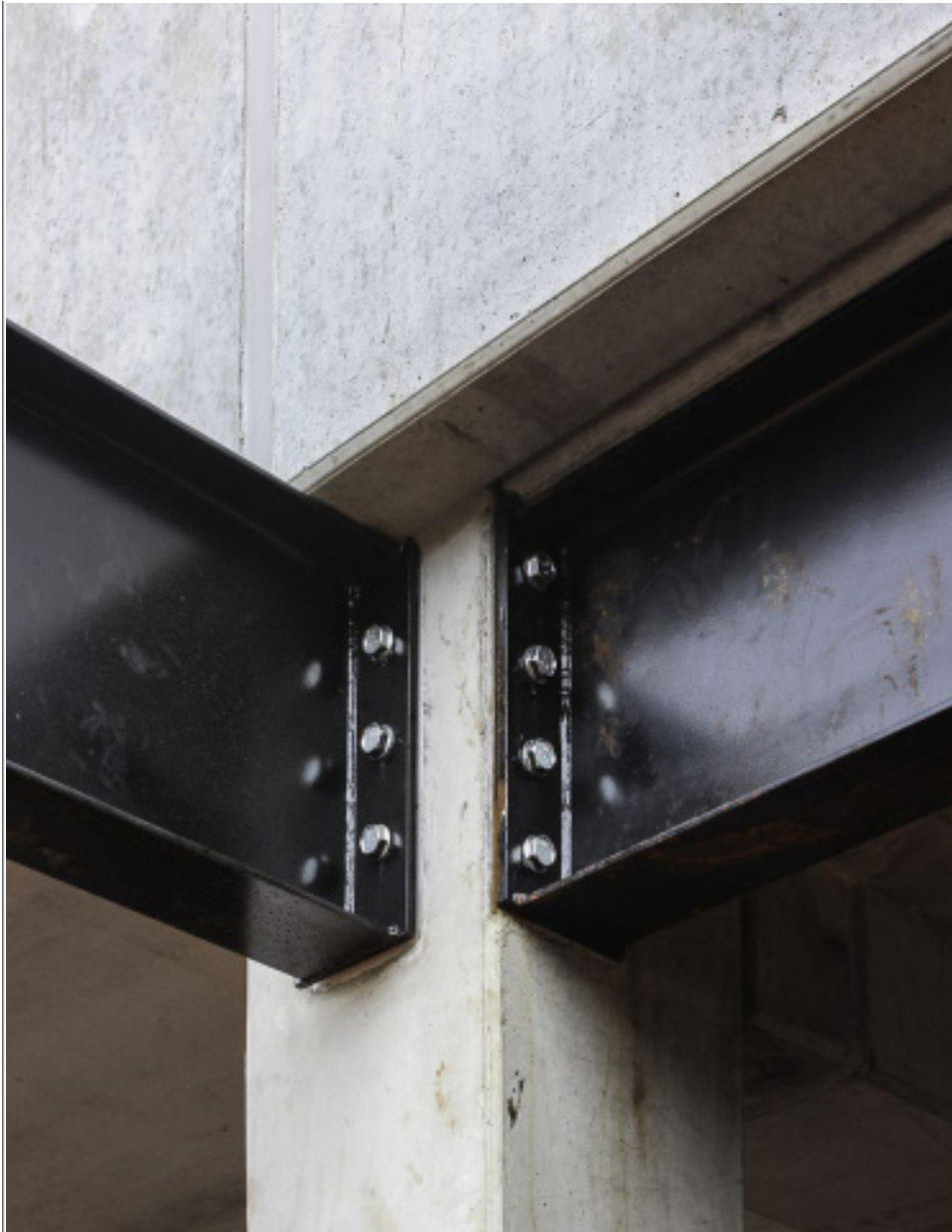
Imagen 156. Unión vigas de acero con concreto
