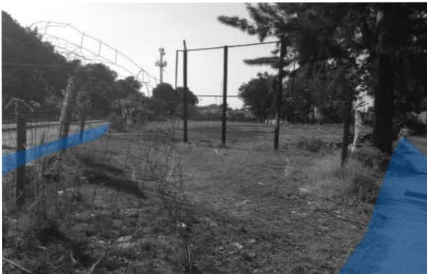
Imagen 46. Condiciones de Banquetas
