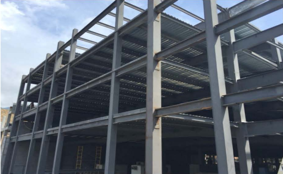
Imagen 157. Unión vigas de acero con concreto
