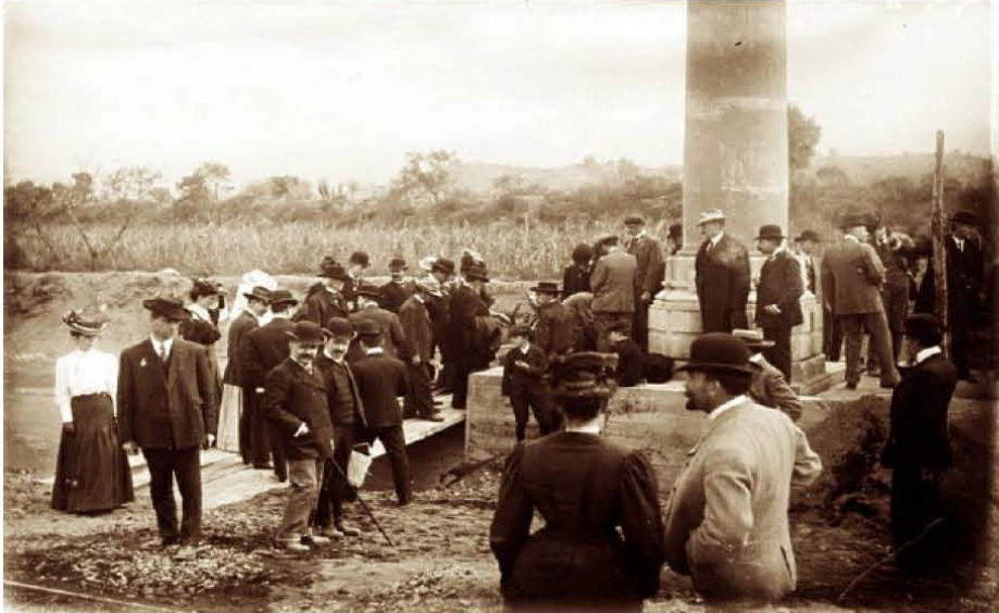
Imagen 7. Construcción del acueducto.
