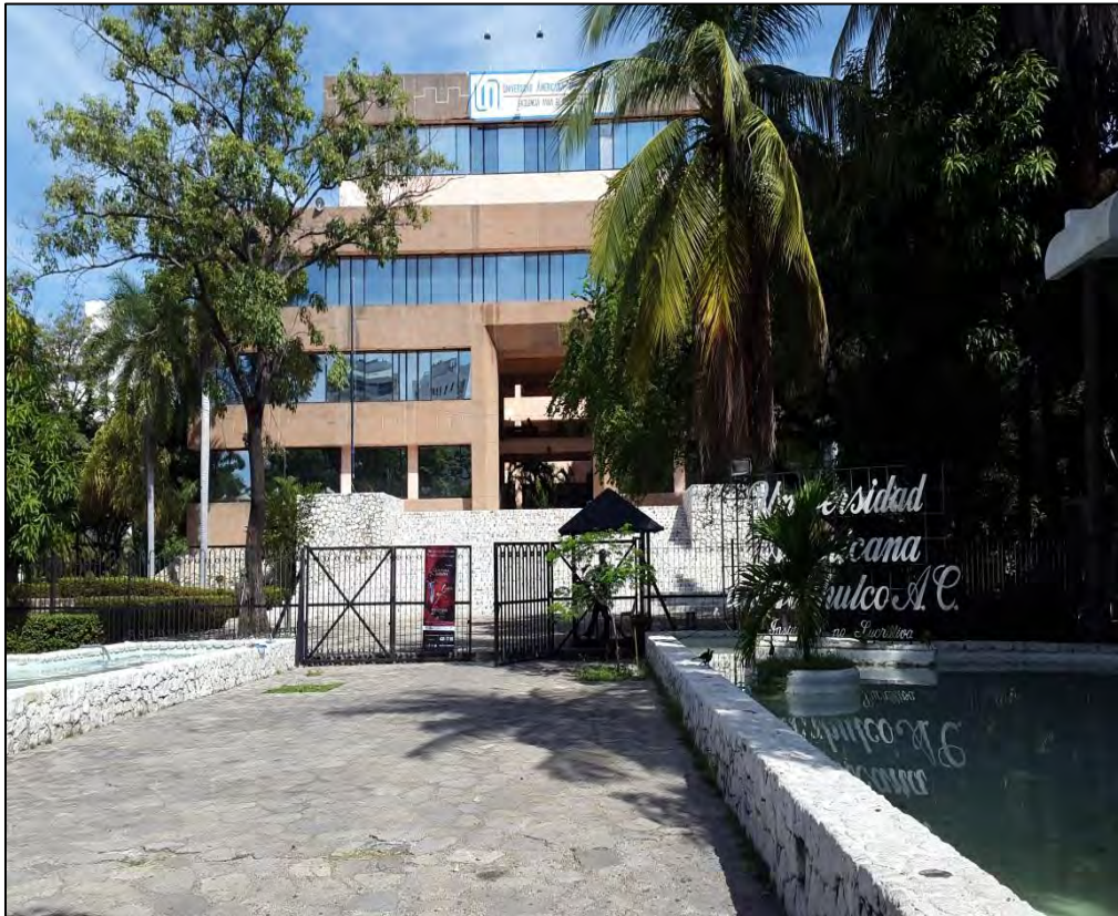
Figura 1.4 Vista principal de la UAA. Fuente de edición propia.
