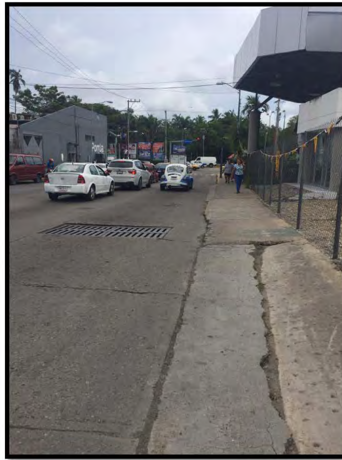
“El Predio cuenta con rejillas para el fácil manejo de las aguas pluviales”.
