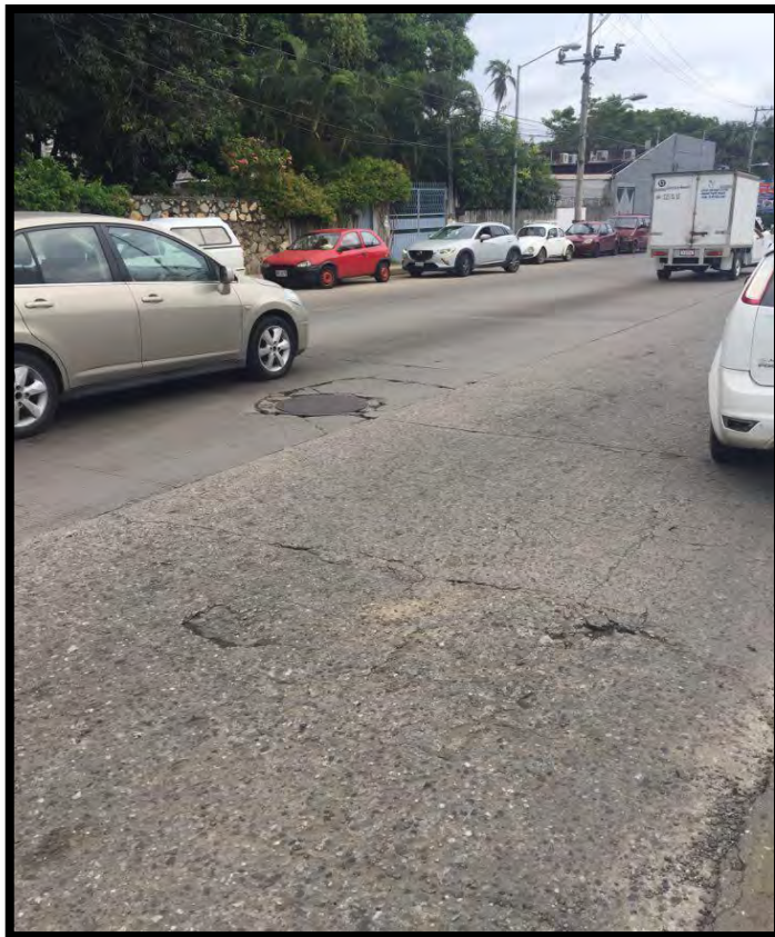
“El Predio cuenta con alcantarillas, vista desde la calle Michoacán”.
