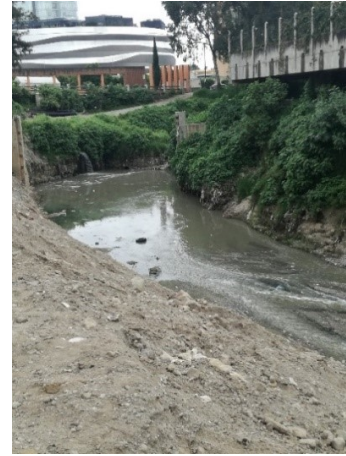
(b) Cauce a cielo abierto (Vista hacia el noreste).
