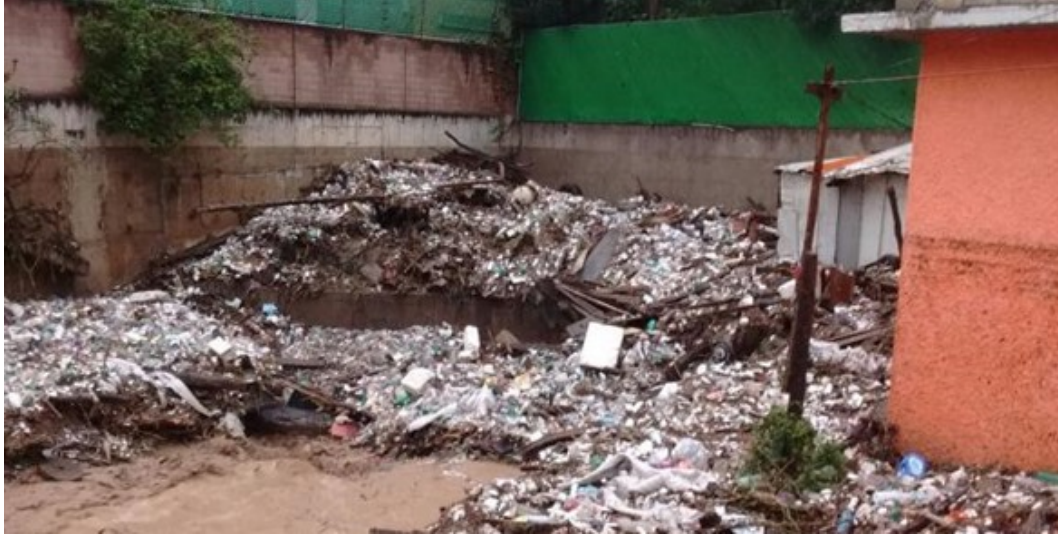
Figura 7-21: Tapón generado por la basura en las entradas al drenaje (Fernández, 2016).
