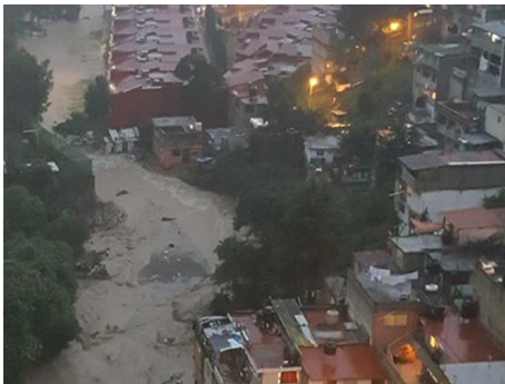
(a) Desborde del río e inundación de los complejos residenciales. (Soler, 2016)
