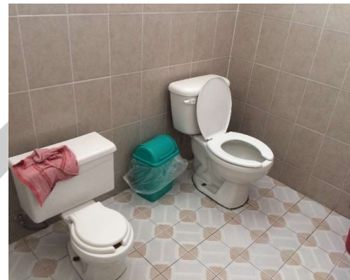
Imagen 61. Baños especiales para el área de pediatría.
