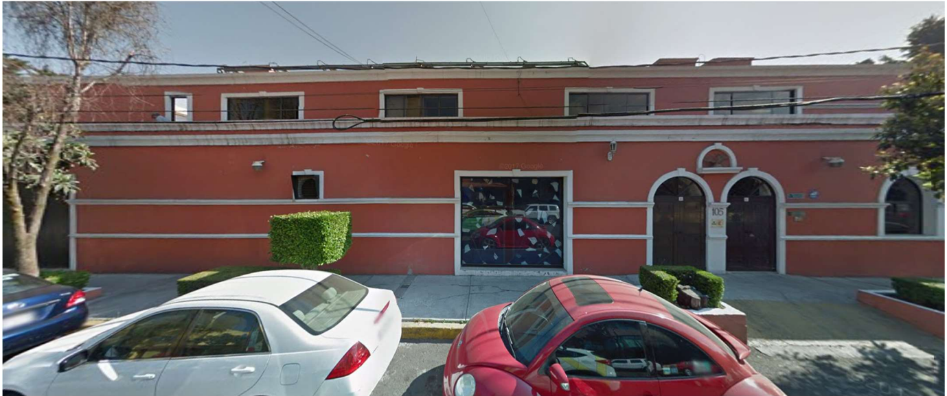
Imagen 47. Fachada Principal (Calle Xontepec).
