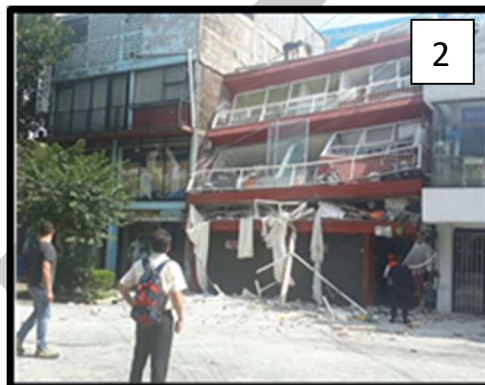
Imagen 33. Edificios colindantes al predio.
