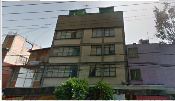
Imagen 14. Fachada Principal del Albergue "Por un hogar".
