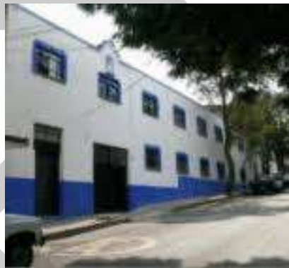
Imagen 15. Fachada Principal del Albergue "Nuestra Señora de Lourdes".
