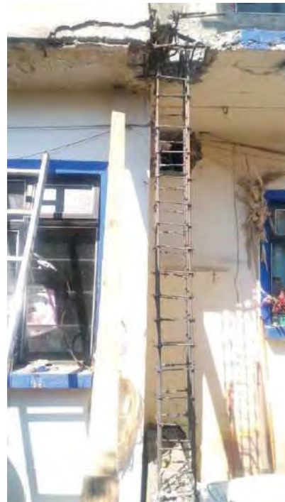
Imagen 24 Apuntalamiento de losa.
