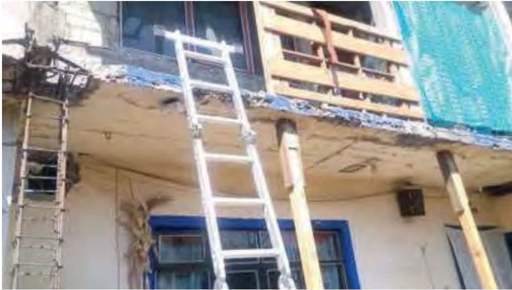
Imagen 25. Apuntalamiento de losa de la vivienda vecina.
