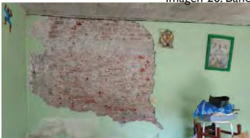
Imagen 27. Muro de la vivienda.
