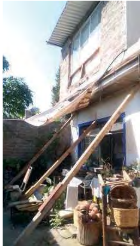
Imagen 29. Apuntalamiento de losa.
