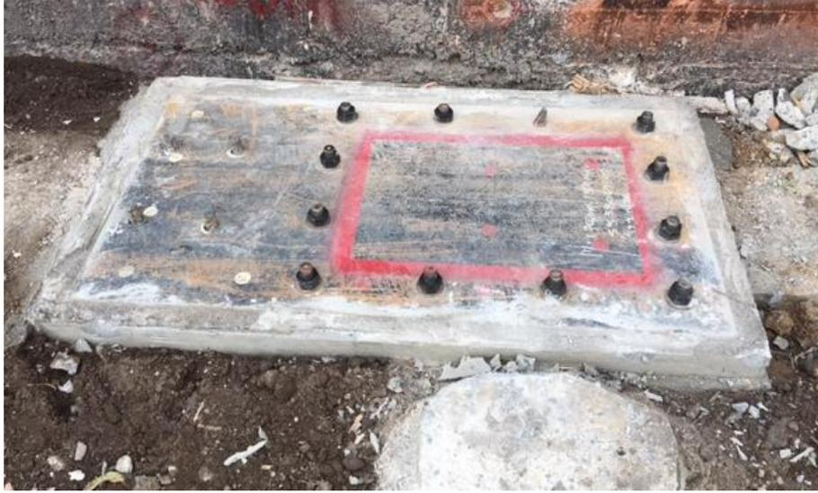
Figura 2.11 Placa de acero corregida
