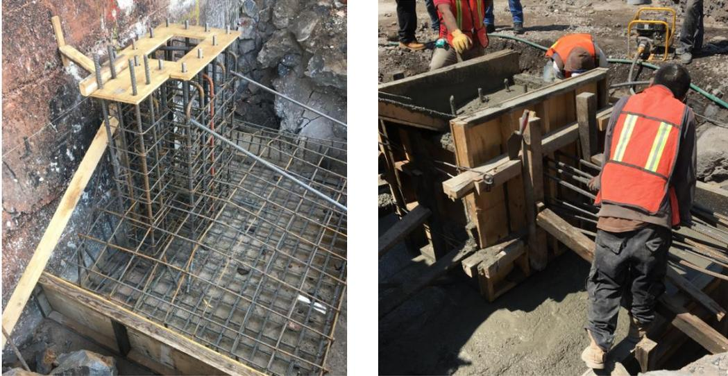
Figura 2.10 Zapatas antes y después de ser coladas
