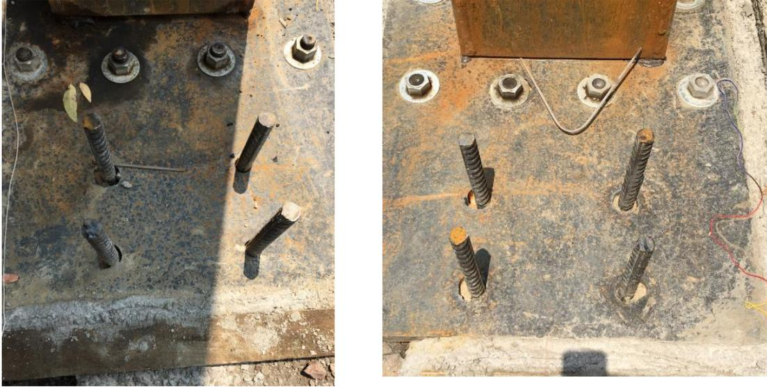
Figura 2.8 Placas base y anclas de zapata
