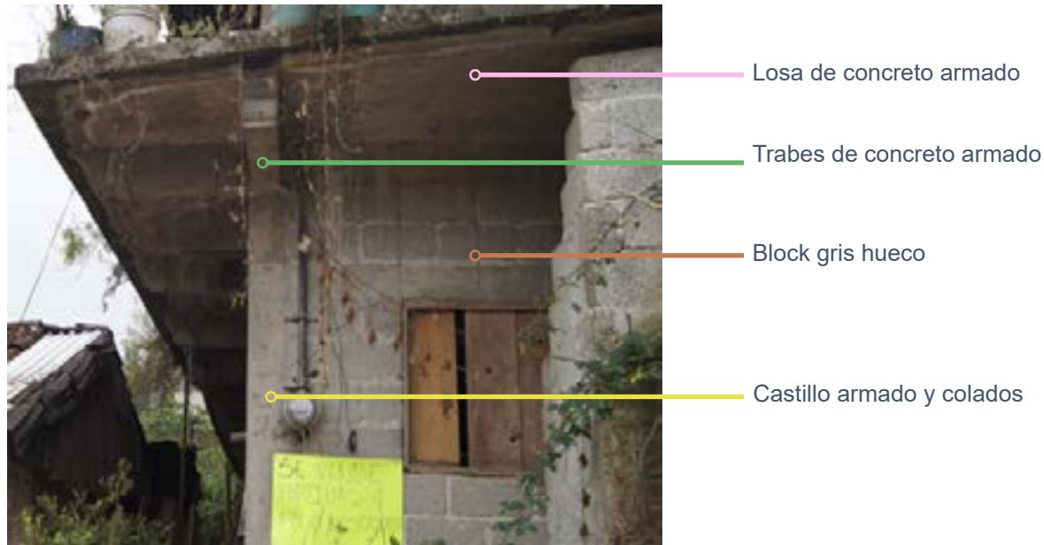
Imagen 24.- La fotografía muestra el sistema constructivo mixto utilizado en la vivienda. Tomada en el trabajo de campo DR© Gabriela Gaitán Barrios
