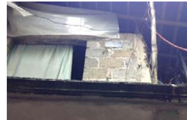
Imagen 13 Fotografía que muestra la losa existente en el entresijo y la cubierta de distintos materiales. Tomada en el trabajo de campo #1 (Enero 2017) D.R.© Magda Gabriela Gaitán Barrios
