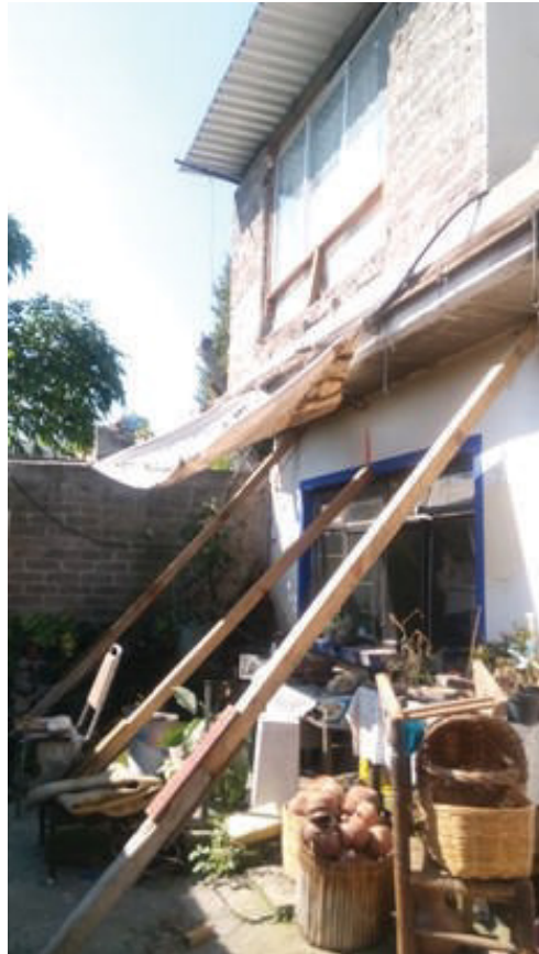
Imagen 29. Apuntalamiento de losa.
