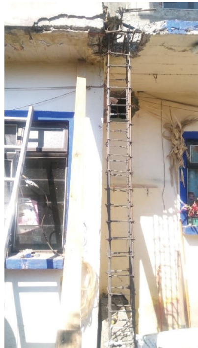
Imagen 24 Apuntalamiento de losa.
