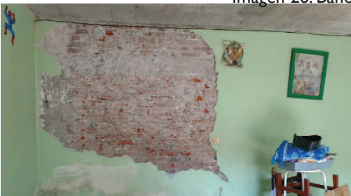
Imagen 27. Muro de la vivienda.
