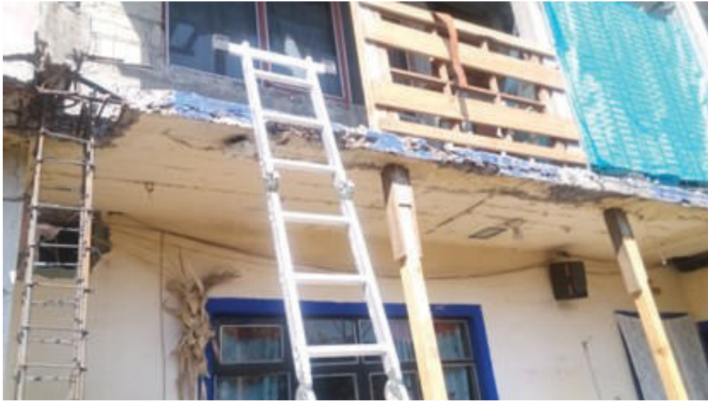
Imagen 25. Apuntalamiento de losa de la vivienda vecina.
