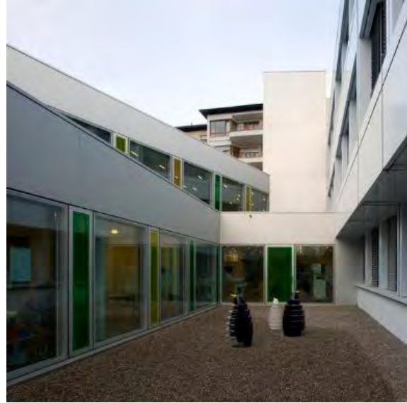
Imagen 24. Patio entre la clínica y el hospital (Tomado de Archdaily México, 2011).
