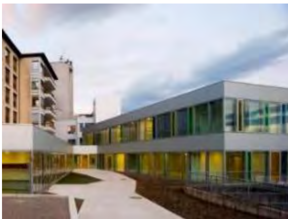
Imagen 17. Corredor de acceso a la clínica (Tomado de Archdaily México, 2011).
