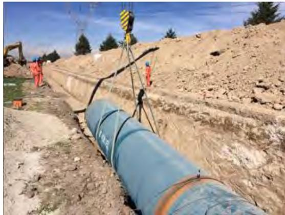
Figura 7. Ensamblaje de tubería.
