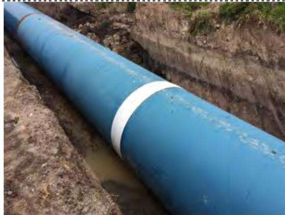
Figura 14. Colocación de cinta mecánica 955
