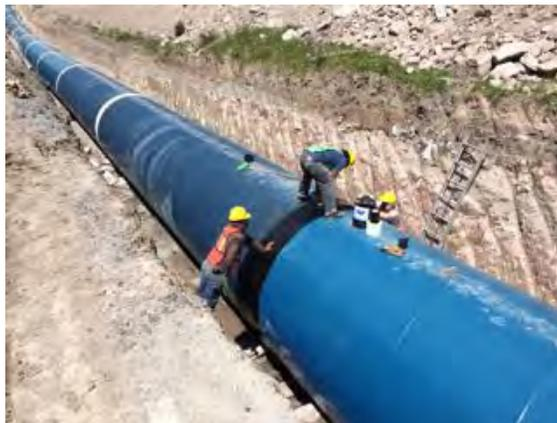
Figura 13. Colocación de cinta anticorrosiva 980
