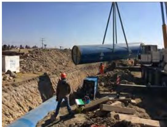
Figura 6. Bajado de tubería en zanja.
