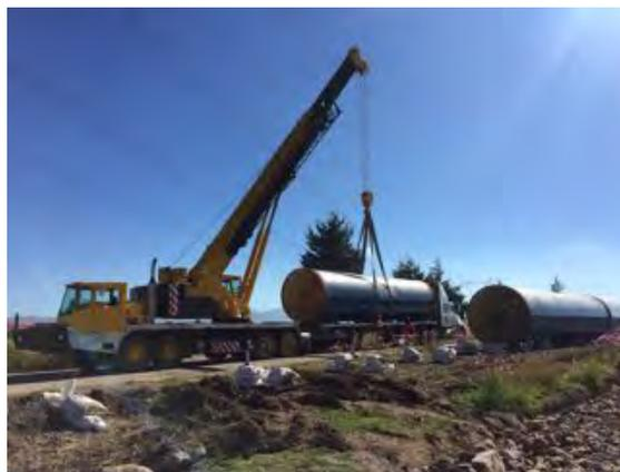
**Figura 2.** Descarga de tubería
