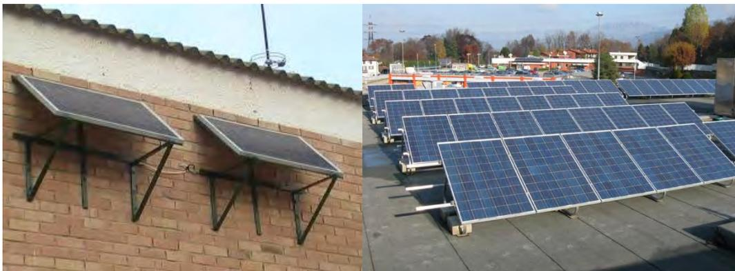
Imagen 14: estructura de superficie plana
