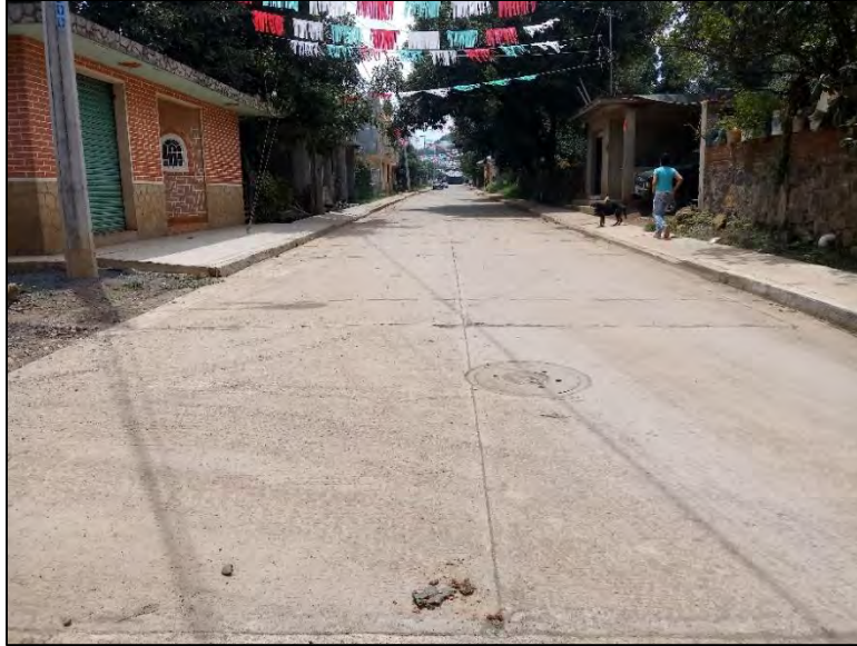
Fotografía 3.8.- Calle principal de las dos colonias.
