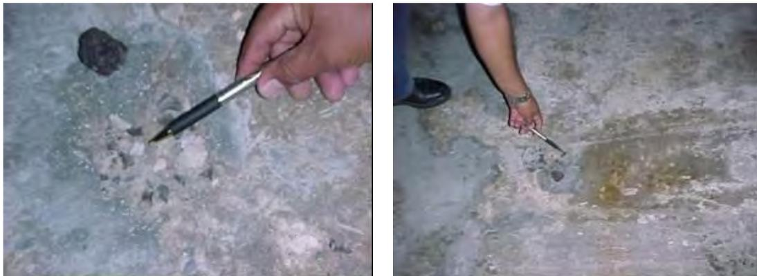
Figura 2.8: Daños por cavitación debido a una varilla en la presa Chicoasén
