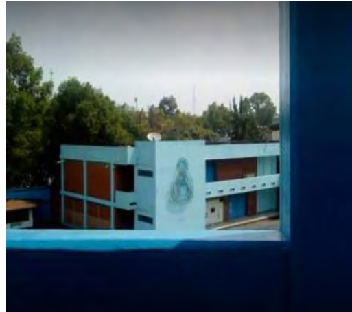
Vista al pasillo
