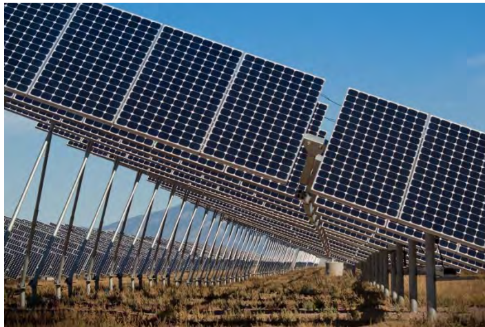
Figura IV.9. Generadores fotovoltaicos con sistema de seguimiento solar
