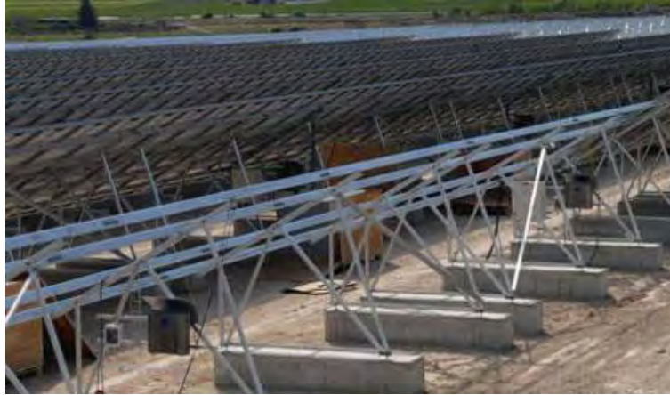
Figura II.16. Estructura de soporte de generadores solares
