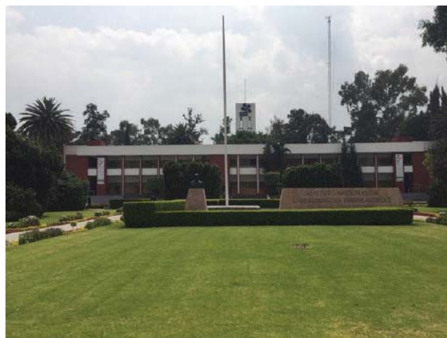
Imagen 5.1 ► Fachada Edificio Principal Instituto Nacional de Enfermedades Respiratorias. Fotografía propia 2017
