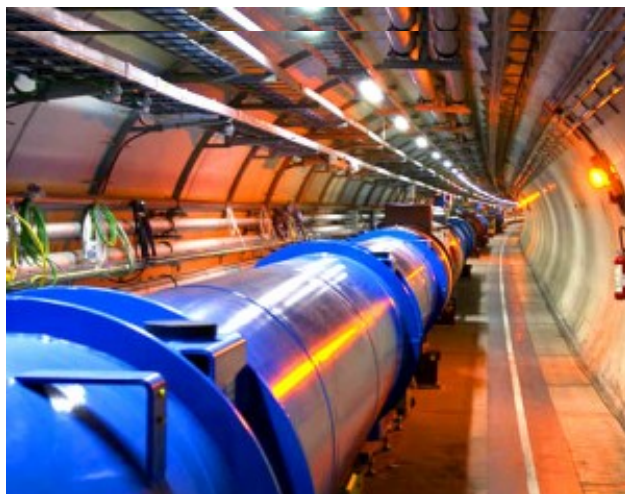
Vista del túnel del LHC
