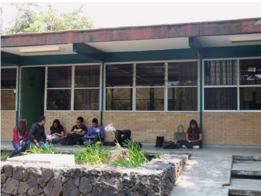
Figura 4.1. Vista externa del aula de clase.
