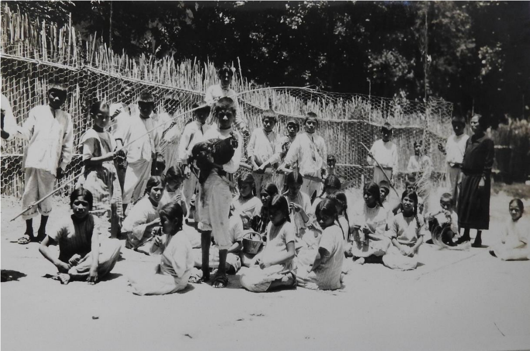
“GALLINERO DE LA ESCUELA FEDERAL”
