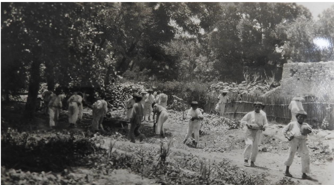
“ALUMNOS DEL 2º AÑO EN LOS TRABAJOS DE CONSTRUCCIÓN DE LA ESCUELA”
