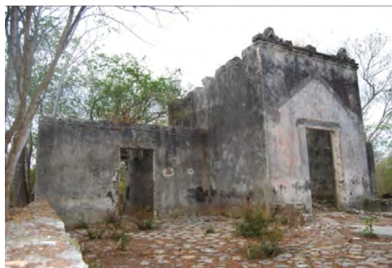
(b) Ruinas de la capilla.
