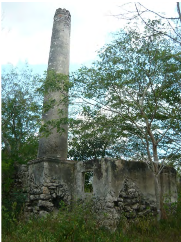
(a) Ruinas de lo que fue el cuarto de máquinas con chimenea
