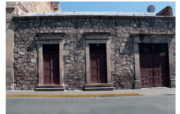
3: Predio en la calle Galeana frente al n. 92
