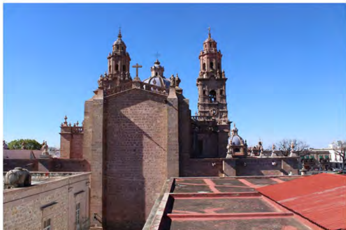
1. Vista desde la azotea "Estacionamiento real" hacia Catedral
