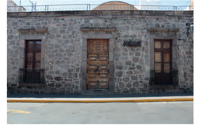
2: Vista frontal a la calle Galeana n. 92
