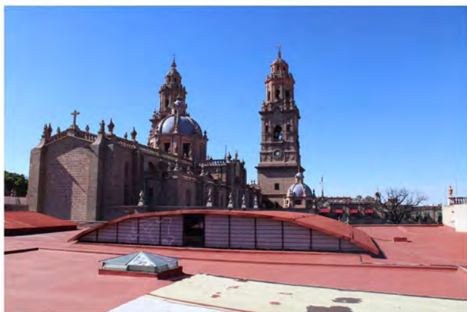
5. Cubierta de "La Parisina"
