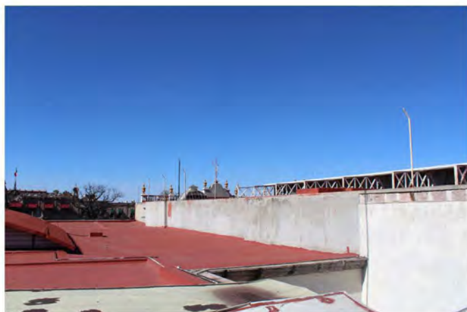
6. Cubierta de "Modatelas"
