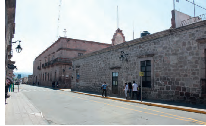
1: Vista al predio de la calle Galeana n. 96
