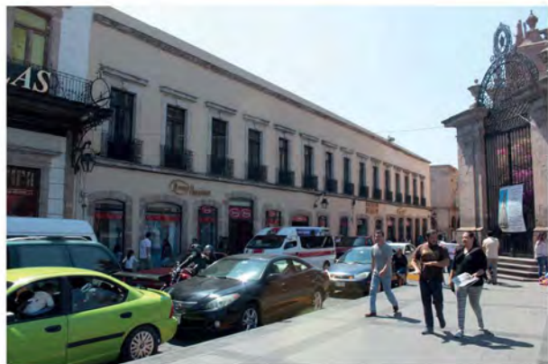
5: Vista al predio de la Calle Allende n. 69
