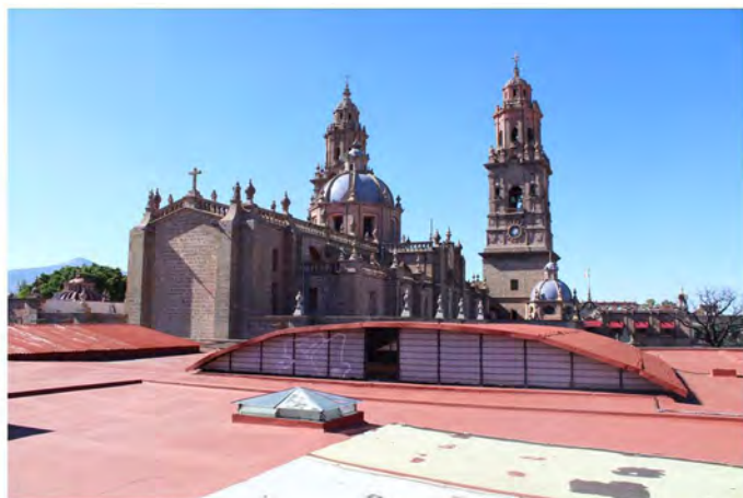
4. Cubierta de la tienda "La Parisina"
