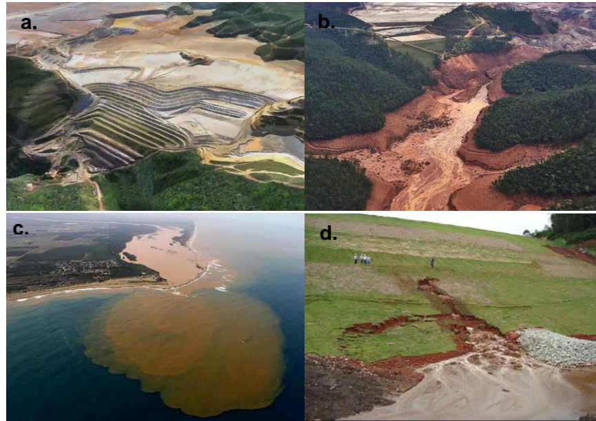
Figura 6.4: Samarco en Brasil en el año 2015, a) Ubicación de la zona que presentó licuación estática b) Vista área de la falla del depósito, c) Relaves que alcanzaron el océano atlántico, y d) Erosión sobre el dique de arranque (Jonsson y Ljunggren, 2010; Morgenstern, Vick, Watts y Viotti, 2016; Van Zyl, 2017).
