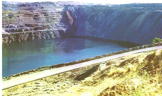
Figura 3.4: Depósito de relaves en una mina a cielo abierto en cierre (European Commission, 2004).
