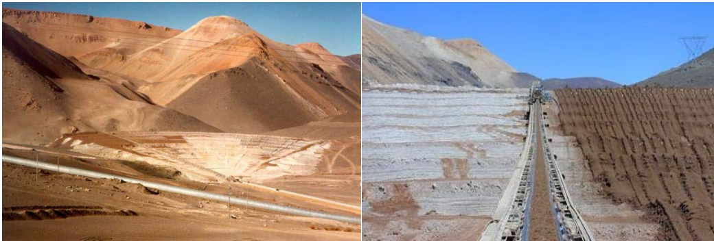
Figura 3.9: Depósito de relaves filtrados en Chile (Martin et al., 2002; Engels, 2017).
