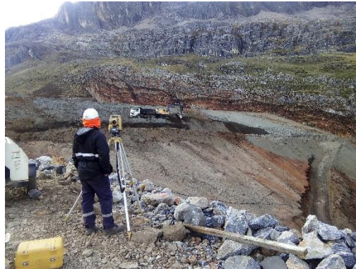
Figura 7.1: Monitoreo de desplazamiento con equipo topográfico (Nyrstar, 2017).
