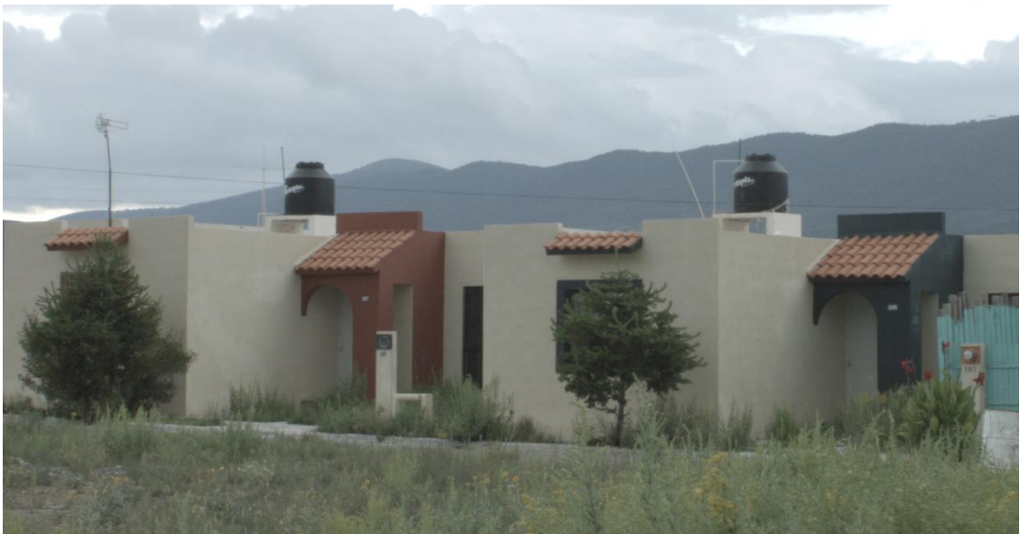
A cinco kilómetros del poblado original, se encuentra la colonia Nuevo Salaverna.
