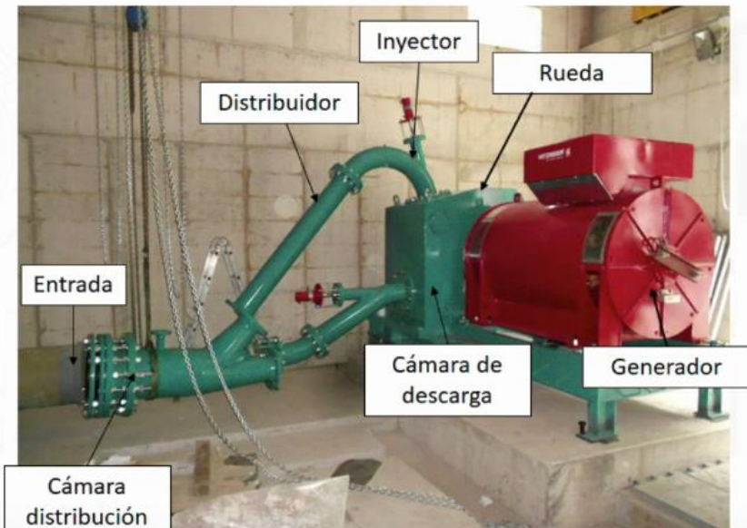
Ilustración 23 Esquema de componentes de turbina Pelton, La Turbina Pelton. Principios Generales . Modesto Pérez Sánchez. Universitat Politècnica de València - UPV. 2017
