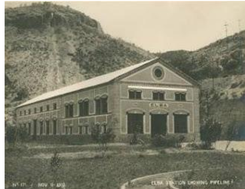
Ilustración 14 Coello Ugalde, José Francisco. Fotografía de la Central Hidroeléctrica "La Planta de Elba". Colección del autor. Perteneciente a la Compañía Eléctrica e Irrigadora del Estado de Hidalgo, y aprovechando la caída del río "Elba", contenía una turbina Picari y un dinamo Alioth, sistema Francis y dos ruedas chicas Pelton. Construida entre 1906 y 1907.
