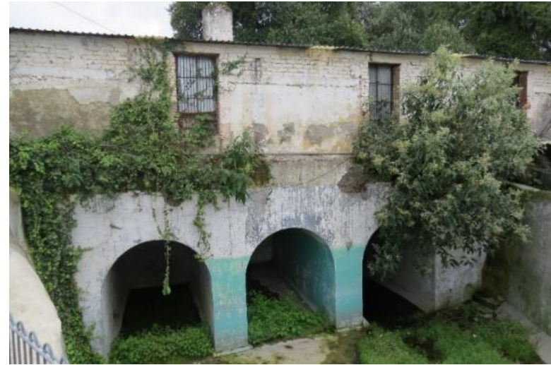
Fotografía 1 Depósito de agua y tres cárcavos en molino de arriba.
