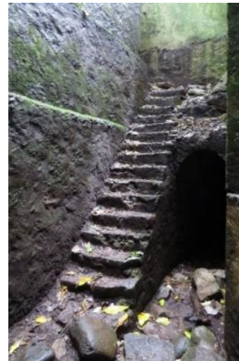
Fotografía 4 Túnel que conduce el agua de los cárcavos hacia el cubo.
