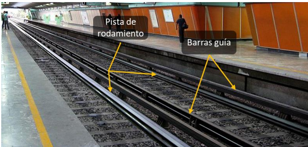
Ilustración II.4 - Vías de un tren de rodadura neumática
