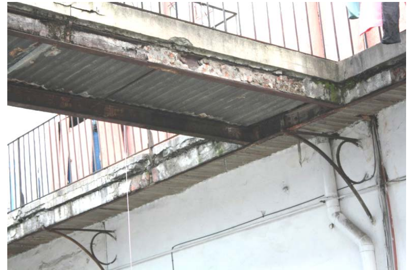
Foto 12. Sistema de vigueta y lámina de acero en andadores Autora, 2017.
