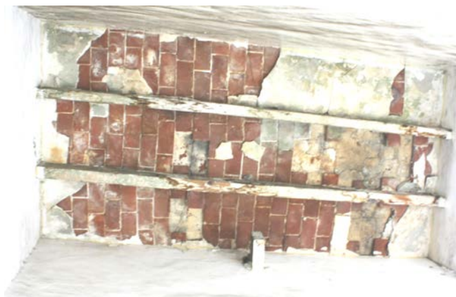
Foto 1. Detalle de la bóveda catalana. Autora, 2017.
