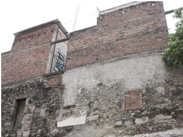
Foto 5. Muros limosneros en primer nivel y muros de tabique en el segundo nivel. Fachada oeste.
