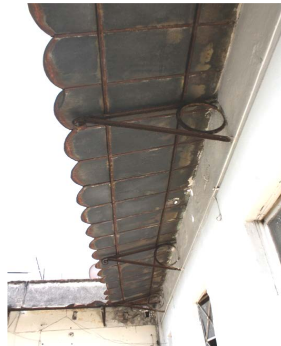
Foto 13. Marquesina de acero y ménsulas. Segundo nivel.
