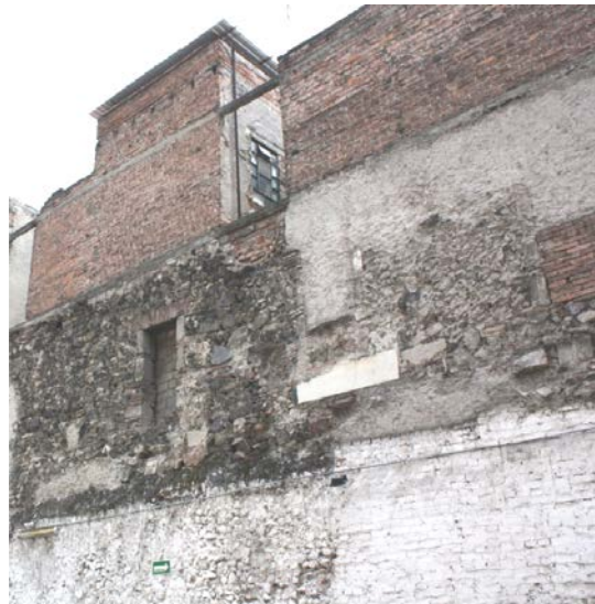
Foto 3. Fachada oeste con la convivencia de muros de mampostería irregular y de ladrillo en el segundo nivel.
