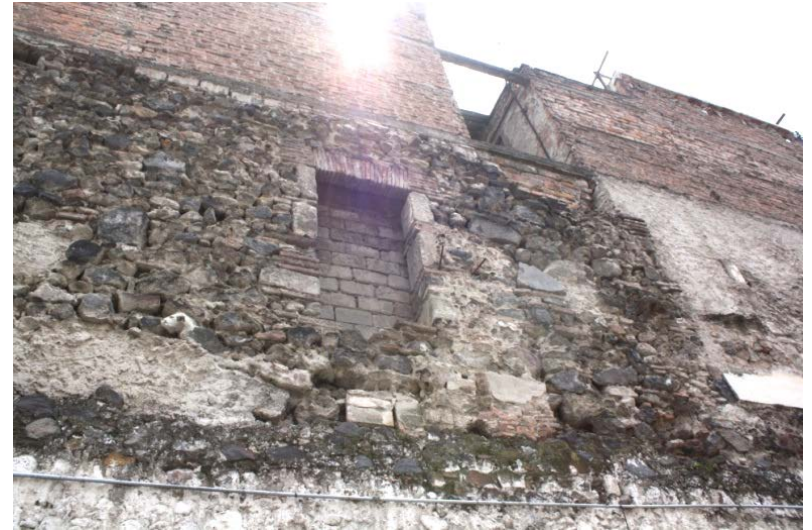
Foto 6. Los dos tipos de muros en la fachada lateral oeste. Se observan ventanas del S. XVIII tapiadas.
