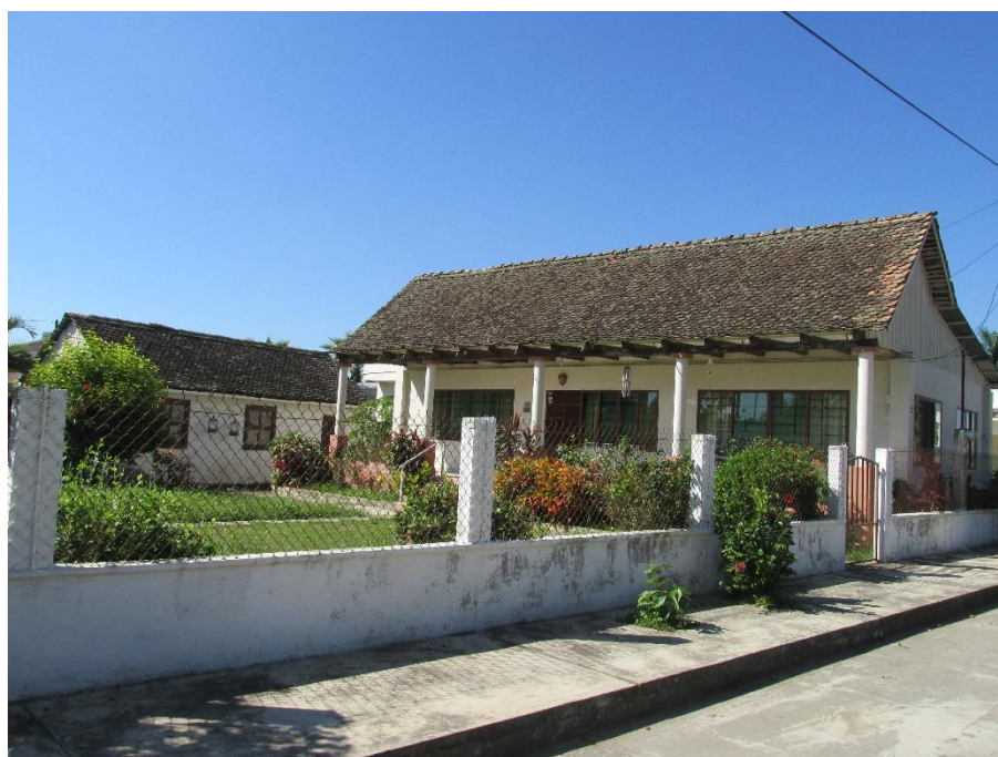
Fotos 9: Techos de tejas en la colonia Centro Tomadas por la autora (18/11/2017)
