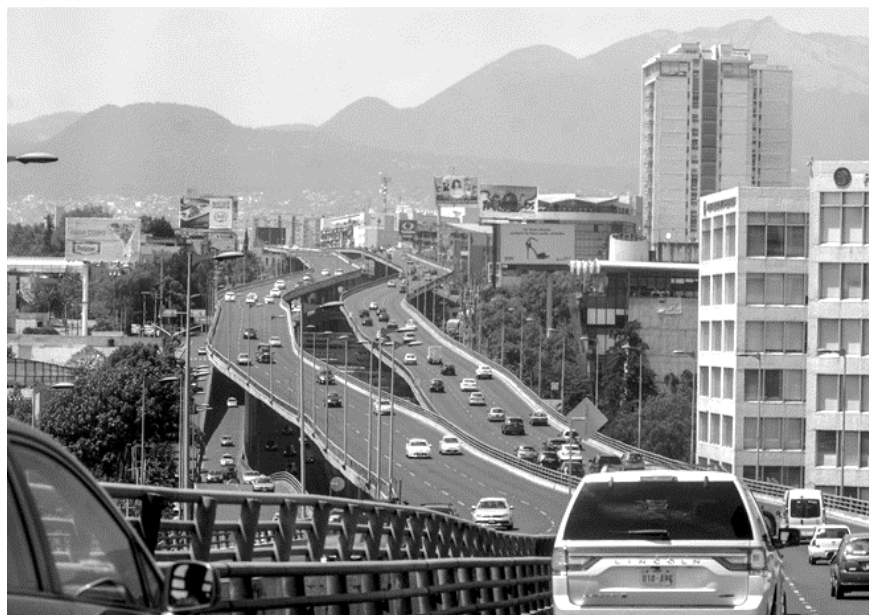
Cambios rápidos en la estructura del entorno: Segundo piso del Periférico
