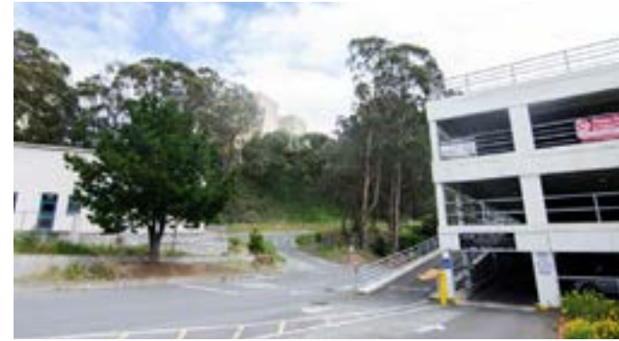
① Vista hacia estacionamiento
