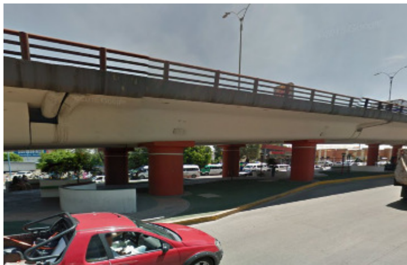
Fig. 14. Cuarto Tramo de Anclaje.
