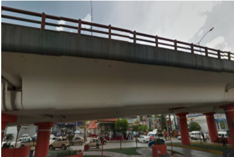
Fig. 9. Primer Tramo Suspendido.
