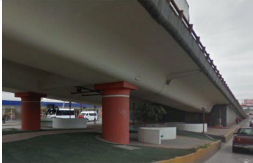
Fig. 15. Cuarto Tramo Suspendido.
