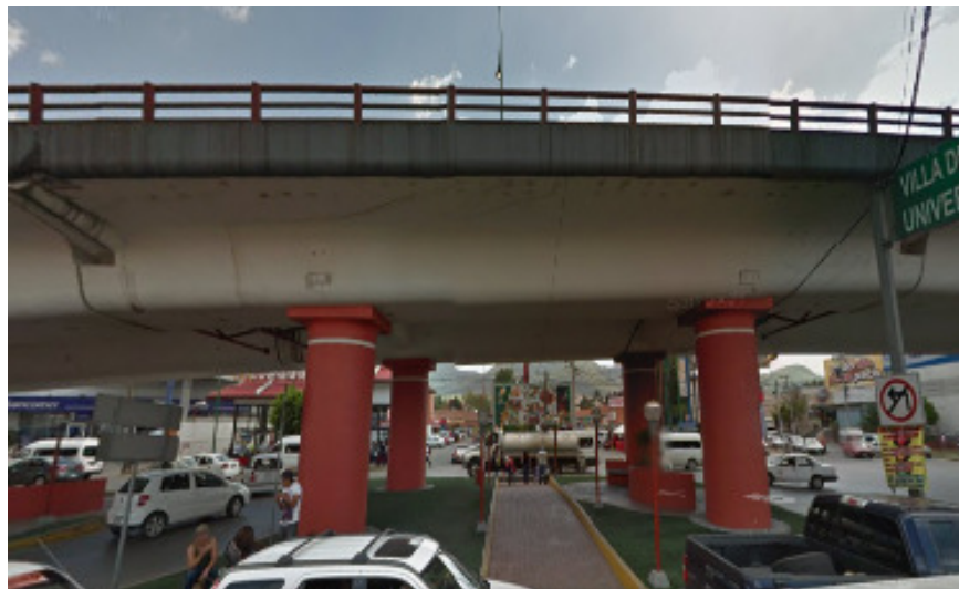
Fig. 10. Segundo Tramo de Anclaje.
