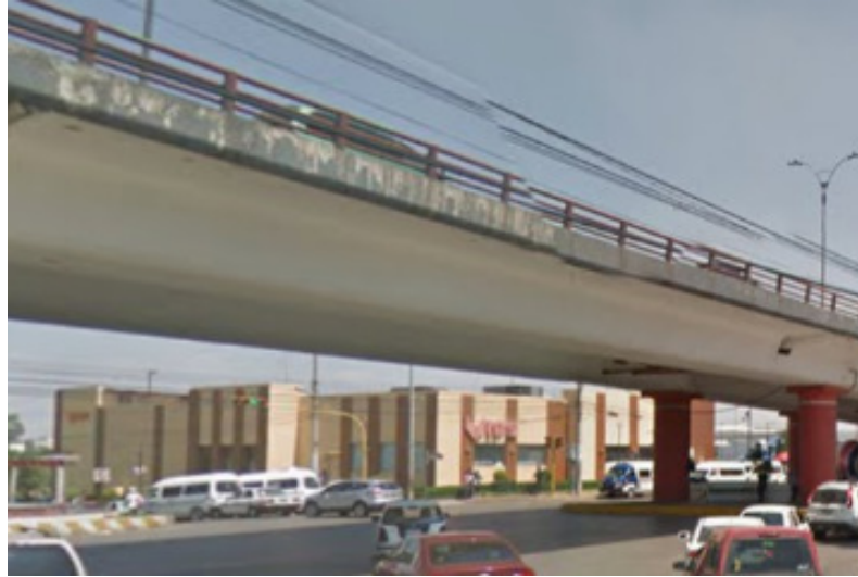
Fig. 11. Segundo Tramo Suspendido.
