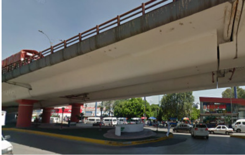
Fig. 13. Tercer Tramo Suspendido.
