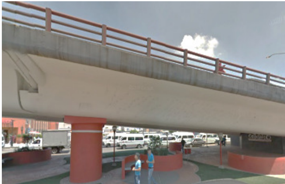
Fig. 8. Primer Tramo de Anclaje.
