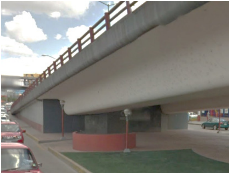
Fig. 6. Tramo de acceso en dirección Ecatepec-Coacalco.
