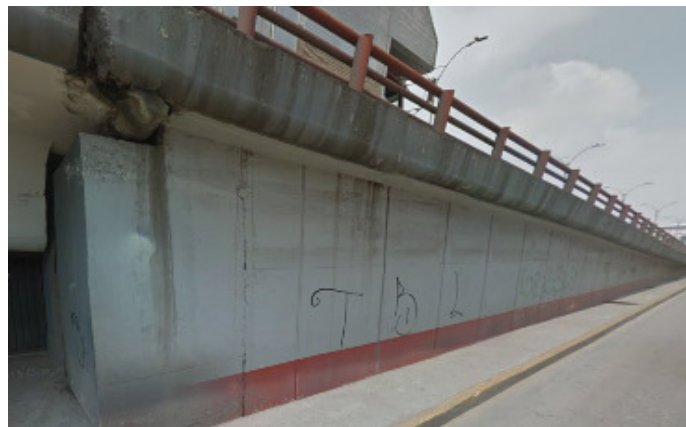
Fig. 16. Estribo de Salida dirección Ecatepec-Coacalco.
