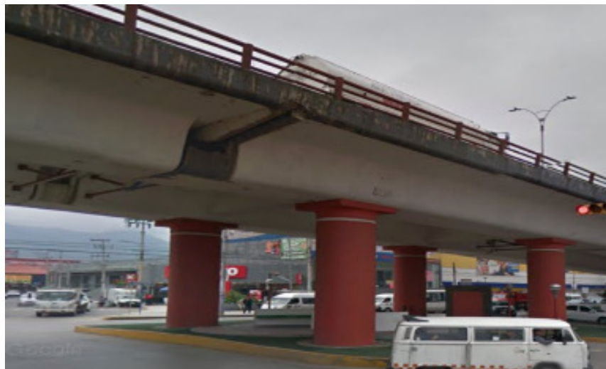
Fig. 12. Tercer Tramo de Anclaje.
