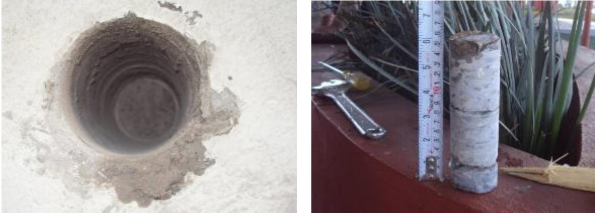
Figura 30. Obtención de muestra de concreto en sitio.
