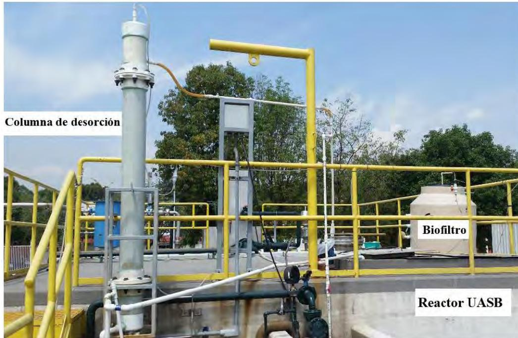
Figura 12. Sistema piloto para la desorción y eliminación biológica de metano y sulfuro de hidrógeno disueltos en el efluente (agua tratada saliente) del reactor UASB. Tomado de Huete Chevez (2017).
