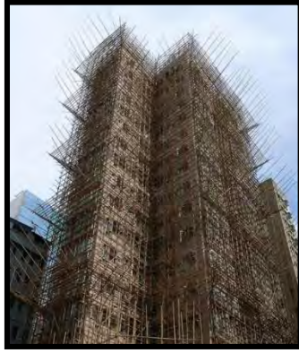
Fig. 7. "Andamiaje de bambú". Fuente: Valhondo, 2003.
