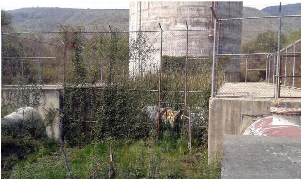
Figura I.12 Tanque unidireccional de 18 m de altura y 18 m de diámetro (Acueducto Chapala-Guadalajara)
