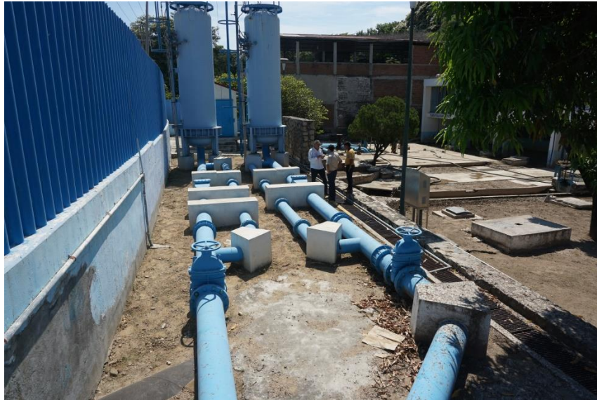
Figura VI.2 Conexiones con las cámaras de aire
