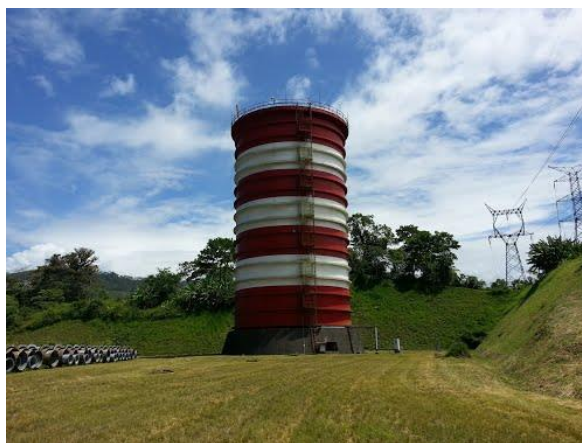
Figura I.11 Torre de oscilación de 52 m de altura (proyecto hidroeléctrico Reventazón, Costa Rica)
