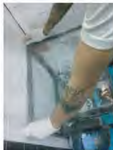
Se coloca plástico cubriendo la zona.
