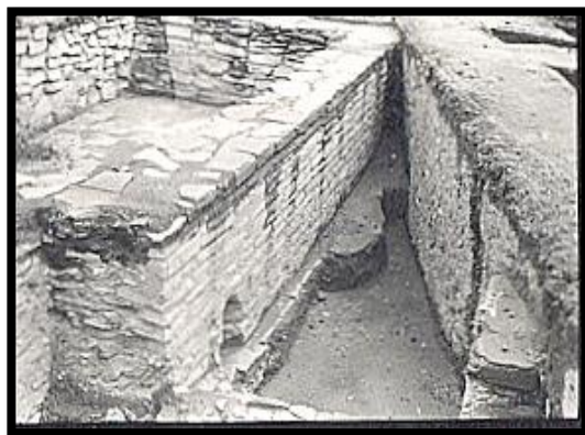
Figura 29. Desagüe del área B
