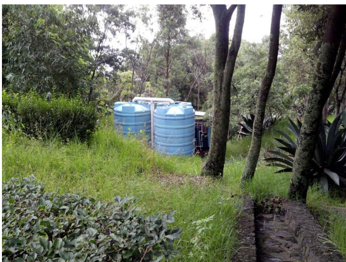
Ilustración 14. Cisternas para la captación de agua pluvial.
