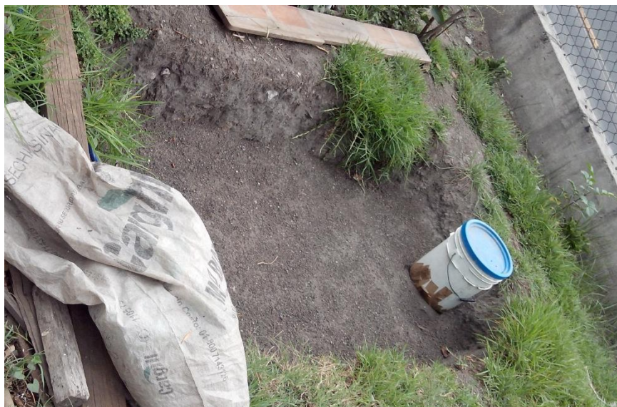
Ilustración 28 Zanja para la creación de una nueva parcela dentro del huerto.
