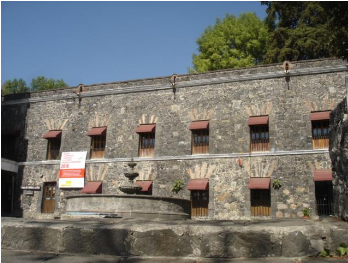
Imagen III. 13 casa patronal, actualmente es la casa de cultura, donde imparten clases de diferente índole. a la derecha, se muestra el interior de la casa de cultura. . Foto tomada por la autora
