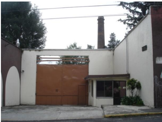
Imagen III.3 Fabrica “La Magdalena”, actualmente Centro de Investigación de Seguridad Nacional (CISEN). Foto tomada por la autora.
