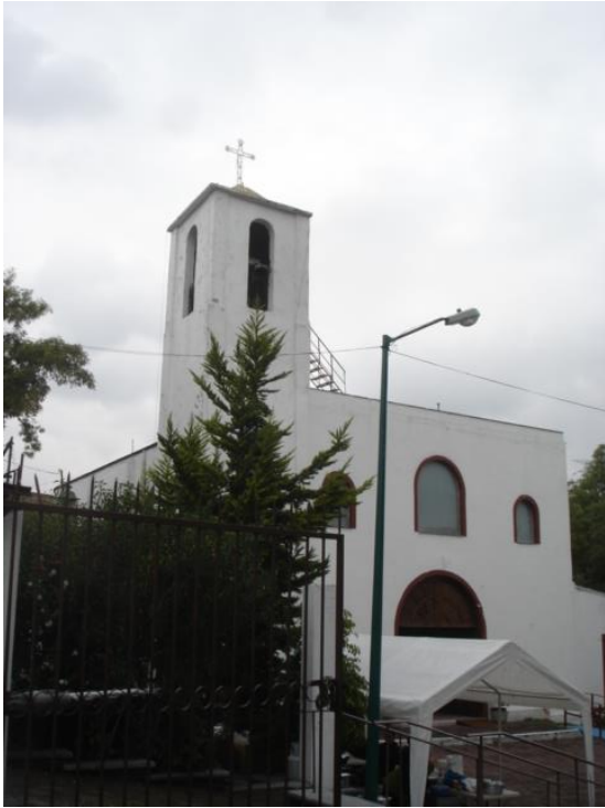
Imagen III. 12 Capilla Santa Teresa. Ubicada sobre Av. México, frente a la ex fábrica Santa Teresa casi en el mismo predio donde se ubicaban las viviendas para los obreros. Foto tomada por la autora
