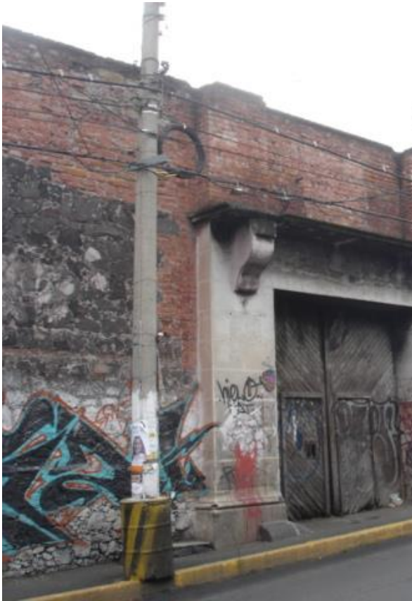
Imagen III.5 Barda Perimetral Santa Teresa sobre la avenida México, donde se puede observar la entrada de la fábrica. Hoy en día, en su interior se localiza el conjunto habitacional santa Teresa. Foto tomada por la autora.
