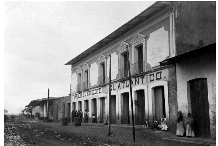
Imagen III. 10 Inicios del tendido de postes de luz en el País. Fuente Fototeca INAH
