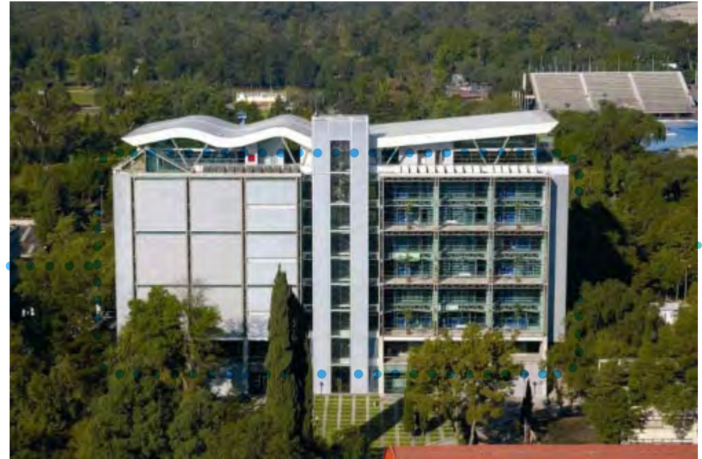
(Imagen 31, Vista oriente del la Torre de Ingeniería. Se puede observar una mitad de la fachada es “muro ciego” mientras que la otra mitad es completamente abierta con los ventanales.)
