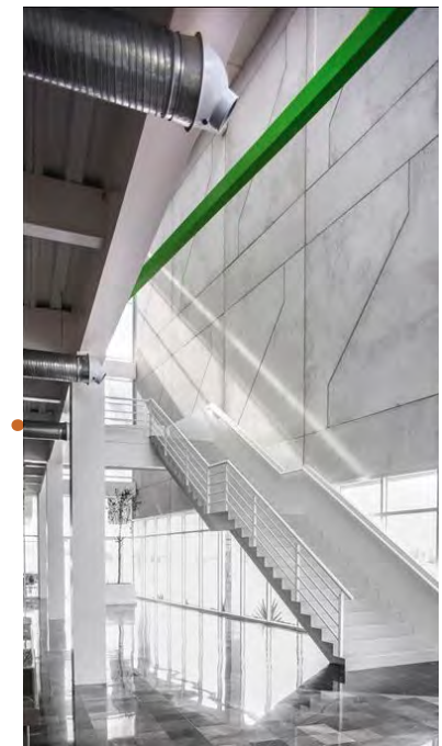
(Imagen 26. Detalle de instalaciones y escalera.)
