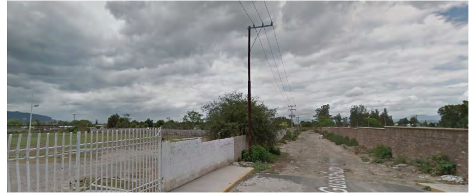
(Imagen 32, Vista B. Vista hacia la calle oriente del predio. Se observa que no se encuentra pavimentada y es una calle de terracería)
