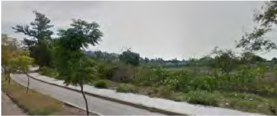
(Imagen 33 Vista C. Vista de la parte norte del predio. Se observa que hay una ciclo pista previo al paso vehicular y que la banqueta tiene alrededor de 1.20m por lo que sería recomendable hacerla más ancha para el paso peatonal.)
