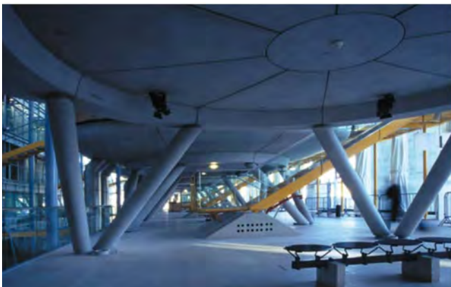
Imagen 19. Tribunales de justicia en Burdeos, Francia, Richard Rogers, 1998. Área de espera conformada por las columnas en planta baja.
