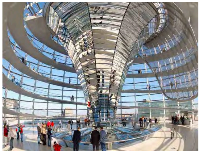
Imagen 18. Cúpula del Reichstag en Berlín, por Foster and Partners, 1999. Costillas radiales y anillos en la circunferencia.
