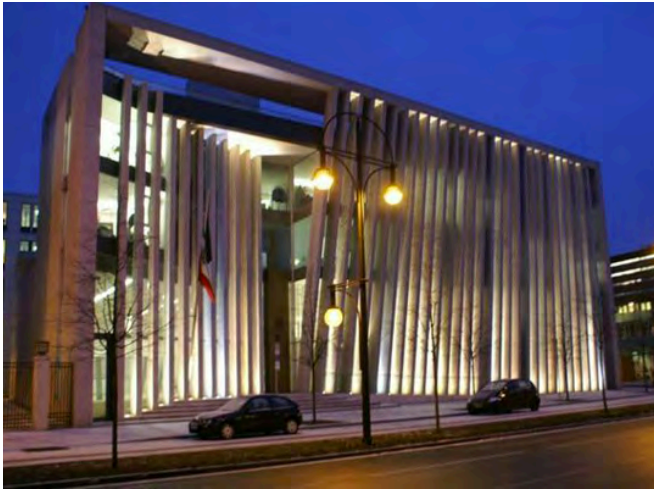
Imagen 17. Embajada de México en Berlín, por González de León y Serrano, 2000. Columnas dinámicas como juego de celosía en fachada.
