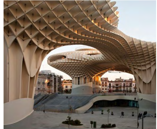
Imagen 6. Estructura de madera.
