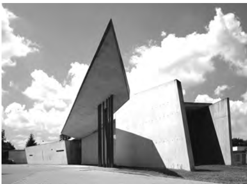
Imagen 13. Estación de bomberos en Vitra
