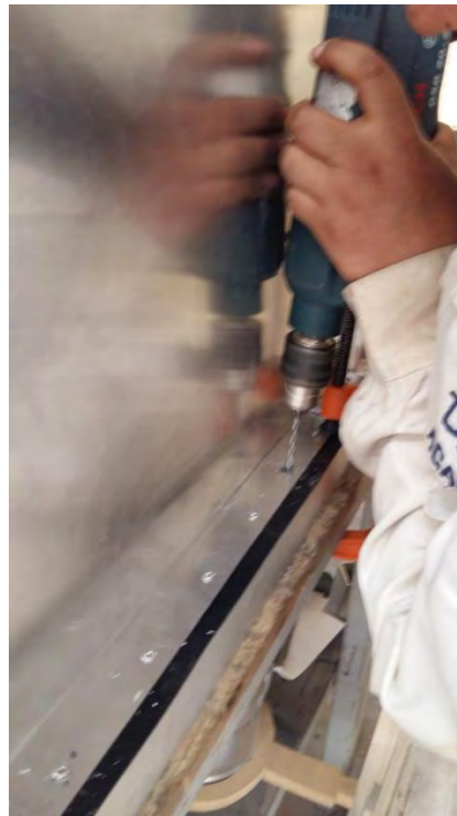
Fig. 85 Barrenado del neopreno y el PTR para la unión con la lámina de aluminio por medio de remaches
