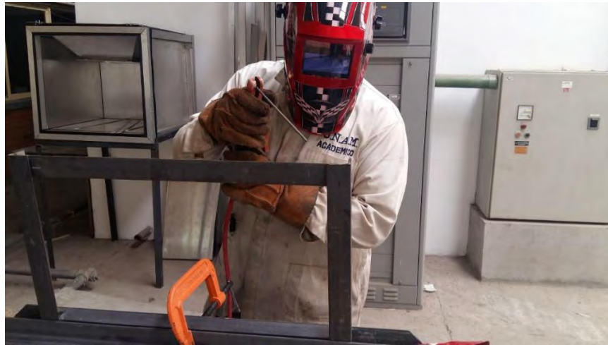
Fig. 169 Soldadura de los tramos de acero para el carrito
