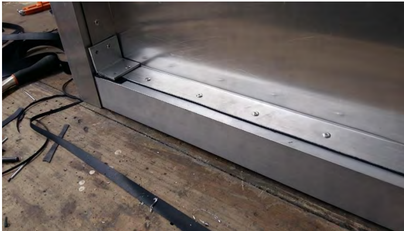
Fig. 86 Colocación de los remaches y corte del sello de neopreno a medida
