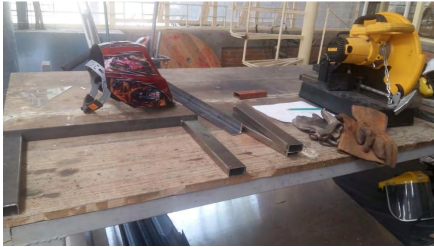
Fig. 172 Corte y soldado de los tramos para construir el banco
