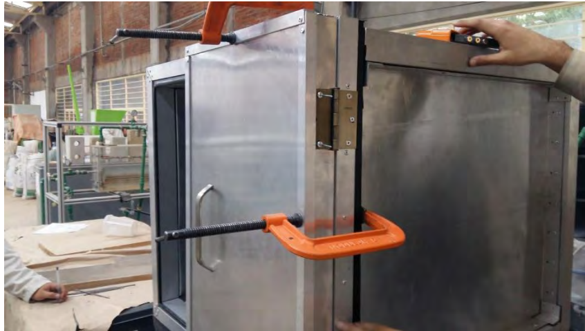
Fig. 100 Bridas para puerta colocadas con remaches
