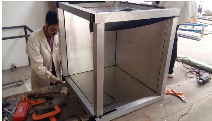
Fig. 87 Estructura de PTR con láminas de aluminio y neopreno
