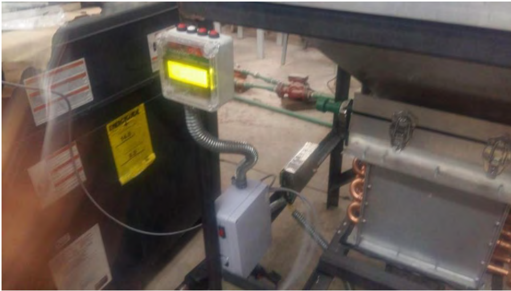
Fig. 176 Instrumentación instalada a la estructura del deshidratador
