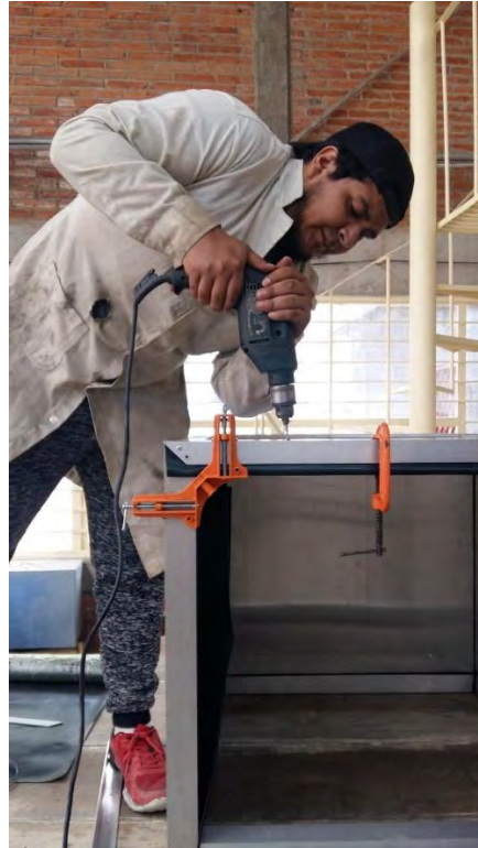
Fig. 88 Colocación del marco de ángulo de aluminio y neopreno
