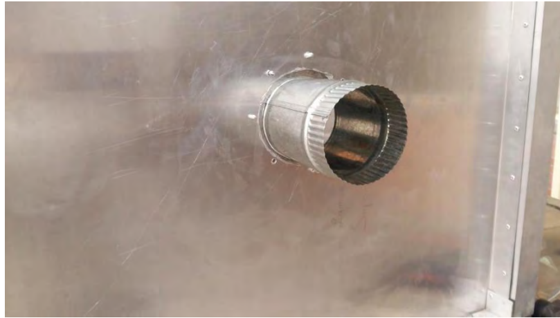
Fig. 91 Instalación de chimenea
