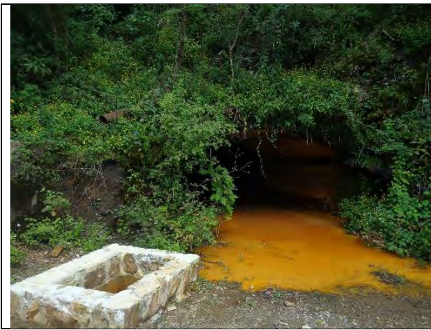
Figura 3. 5. Socavón 1412, mina inactiva
