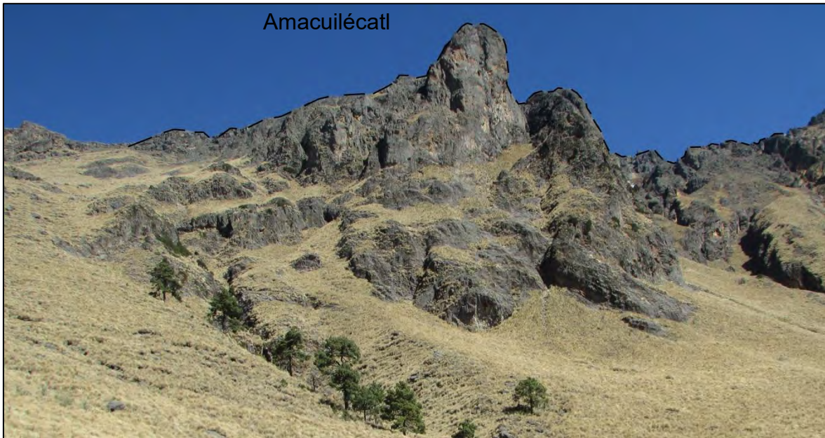
Figura 34. Ladera occidental del edificio de los Pies, se encuentra delimitada la estructura relicto conocida como Amacuilécatl (Diciembre, 2017).
