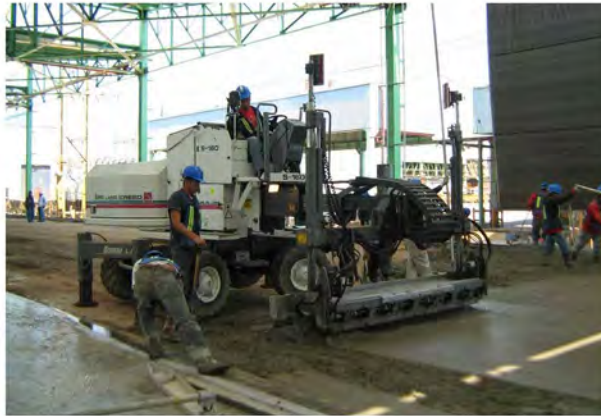
Figura 1.2 Proceso de enrasado del concreto mediante máquina láser
