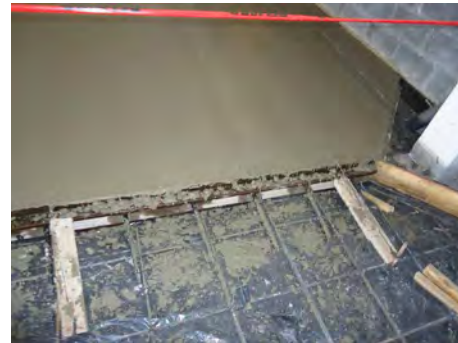
Figura 1.23 Porción de piso colada y porción por colar donde se muestra la junta de expansión con la cimbra de límite de losa y sus pasadores así como la cimbra para la junta de aislamiento en la columna metálica
