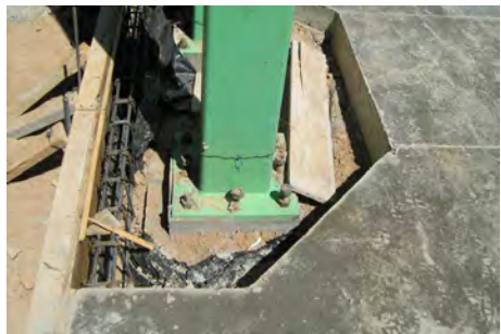
Figura 1.10 Cimbra de madera en límite de losa con junta de aislamiento en la columna metálica y armado de acero para un dentellón perimetral
