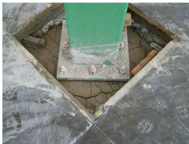
Figura 1.4 Junta de aislamiento para columna (diamante)
