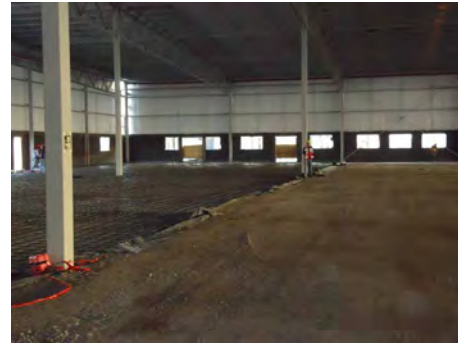
Figura 1.17 Izquierda: la sección del piso lista para recibir el concreto. Derecha: la base terminada y preparada para recibir la barrera de vapor y el acero de refuerzo
