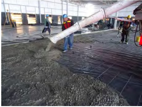
Figura 1.20 Colado de piso con acero de refuerzo
