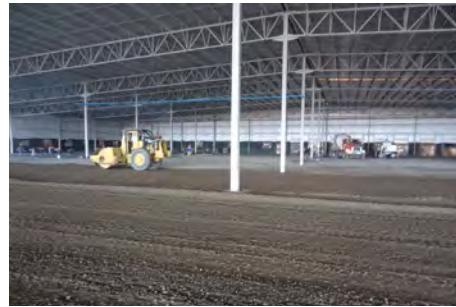
Figura 1.9 Extendido y compactado de grava como base para recibir el concreto
