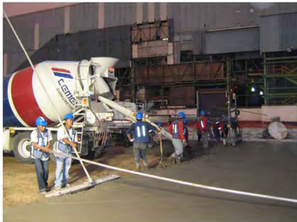
Figura 1.3 Proceso de flotado manual mediante llana bull-float
