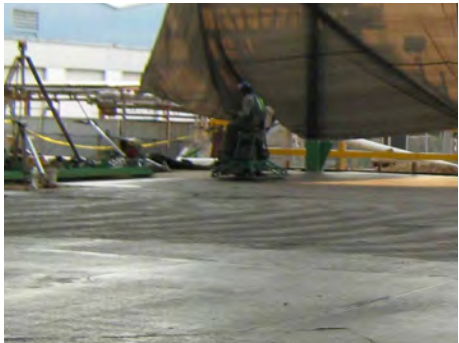
Figura 1.22 Proceso de pulido con allanadora doble
