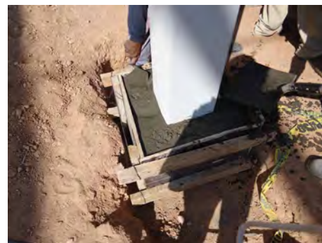
Figura 1.19 Colado de dado de concreto en columna metálica para crear una junta de aislamiento con respecto al piso
