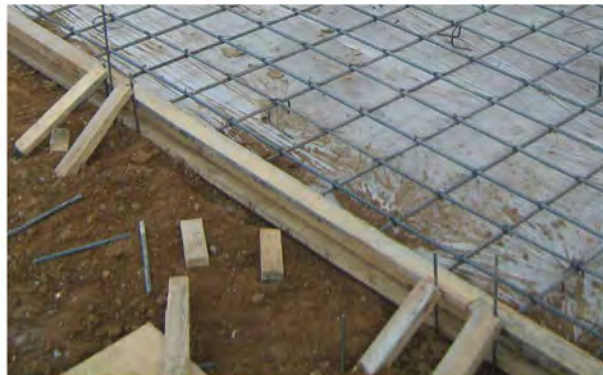
Figura 1.1 Ejemplo típico de cimbra de madera para límite de losa de piso
