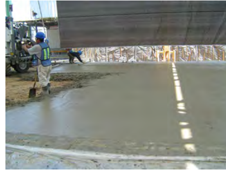
Figura 1.21 Colado de piso con fibras de acero
