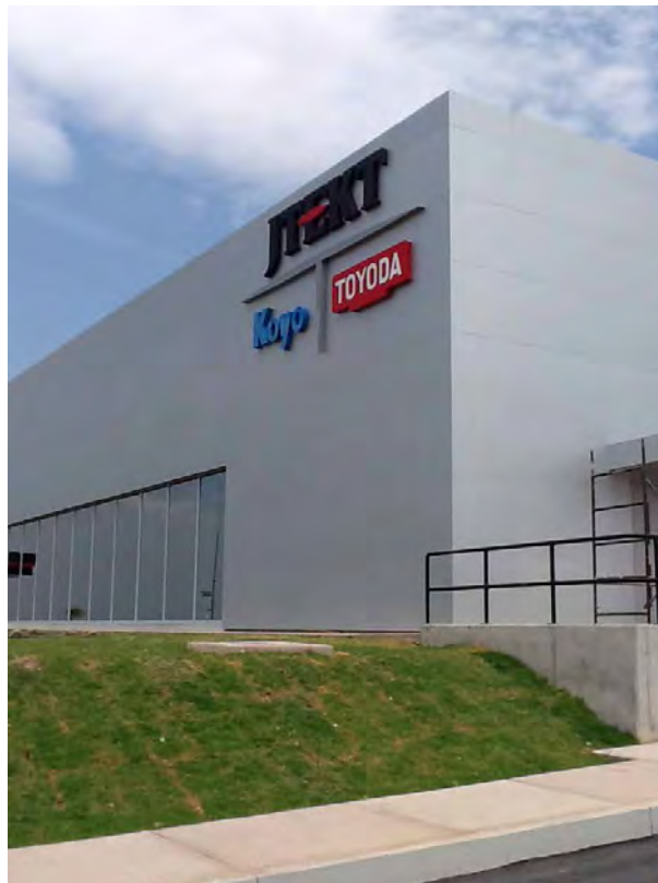
Figura 1.7 Vista exterior de la planta de Jtekt
