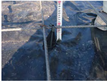
Figura 1.16 Instalación de silleta plástica
