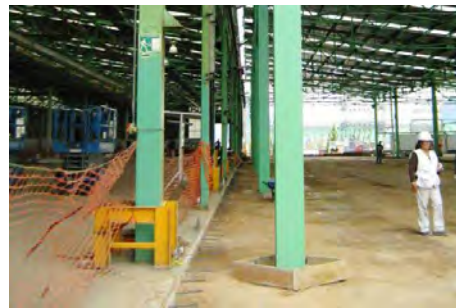
Figura 1.11 Cimbra para la junta de aislamiento en las columnas metálicas (diamante)
