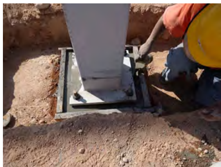
Figura 1.18 Colado de grout debajo de la placa base
