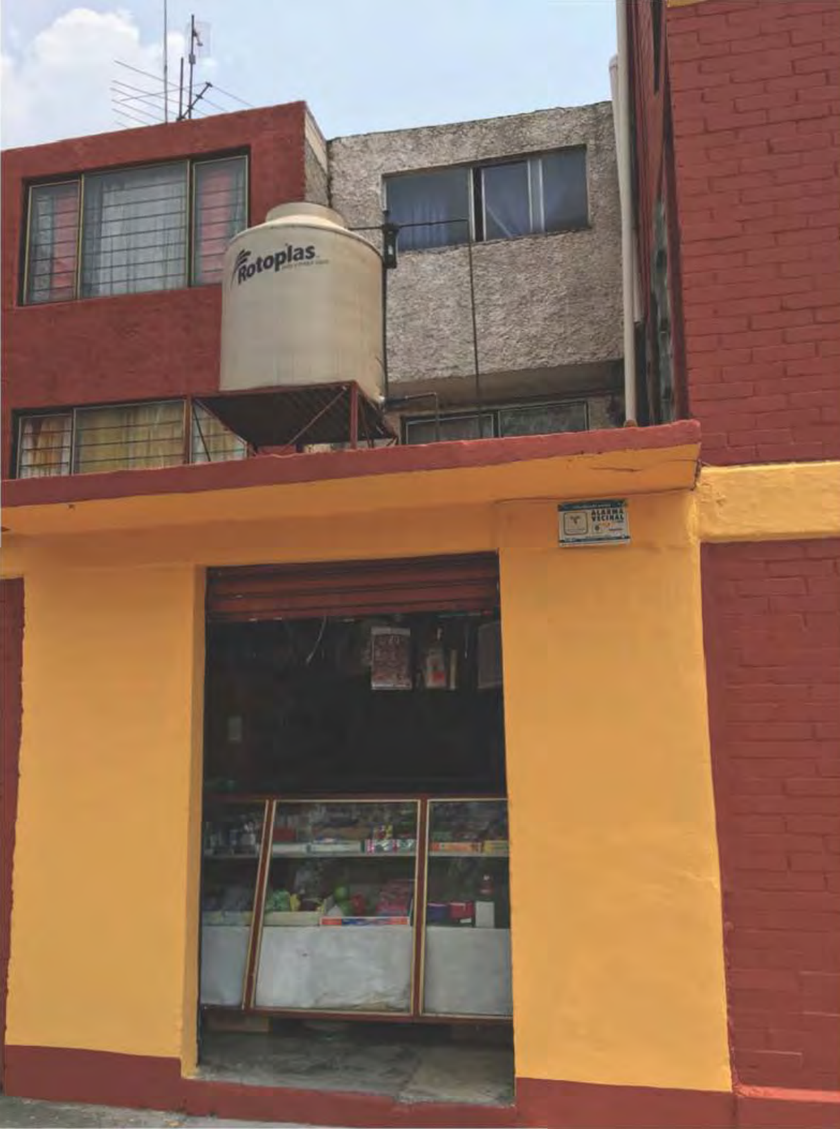
Imagen 4.35. F Fotografía del local comercial que construyeron los habitantes en lo que originalmente era su jardín, además al fondo de la imagen se puede ver la ampliación constructiva de todos los niveles. Fuente: Propia 2017
