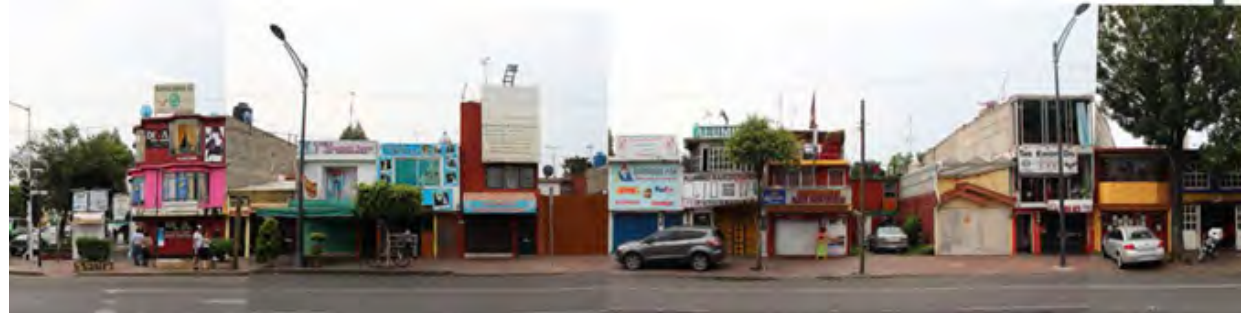
Imagen 1.34. Viviendas Unifamiliares de la sección Piloto con modificaciones por comercios en planta baja Fuente: Propia 2017
