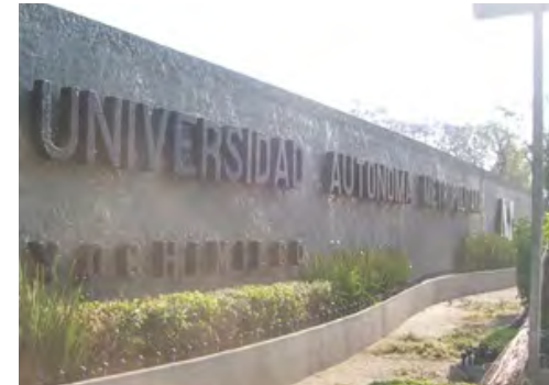
Imagen 1.28. UAM Xochimilco. Fuente: Levantamientos del Laboratorio de Vivienda 2014
