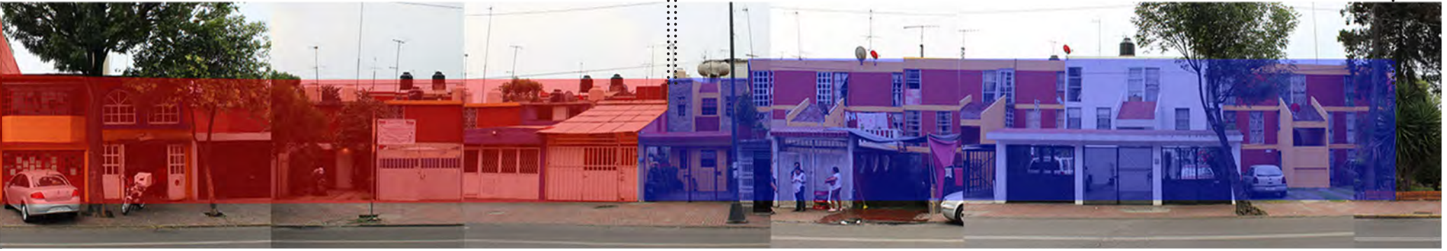
Imagen 3.5 Estado Actual, larguillo de las viviendas unifamiliares ubicadas en el Eje 3 OTE Carlota Romero. Fuente: propia 2017
