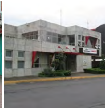
Imagen 1.27. Estación de bomberos. Fuente: Lev. Lab. de Vivienda 2014
