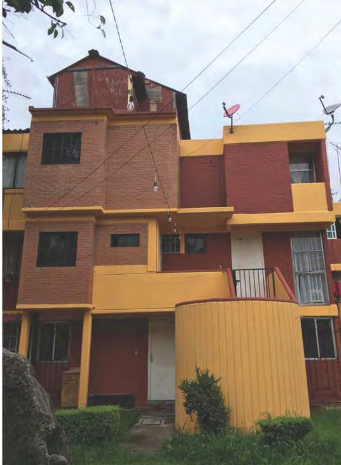
Imagen 3.38. Vivienda con modificación por construcción ubicada en el Bloque 12. Fuente: propia 2017
