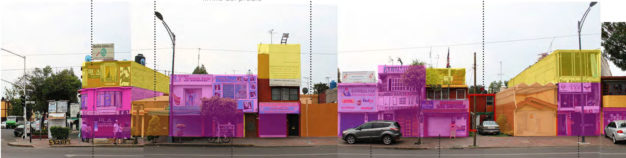
Cambio de uso de suelo. Construcción de comercios en la planta baja y primer nivel de las viviendas
