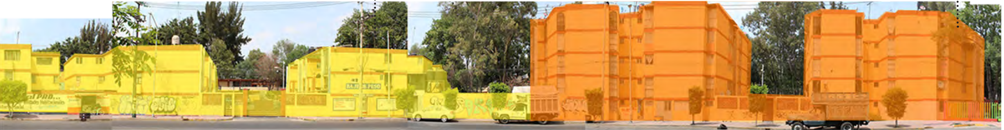
Imagen 3.7 Estado Actual, larguillo de las viviendas multifamiliares ubicadas en Av. Calzada de la Virgen. Fuente: propia 2017
