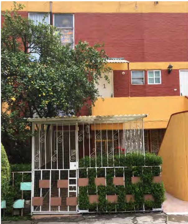
Imagen 3.33. Vivienda triplex ubicada en el bloque 3 con modificación por barrera física PB. Fuente: propia 2017
