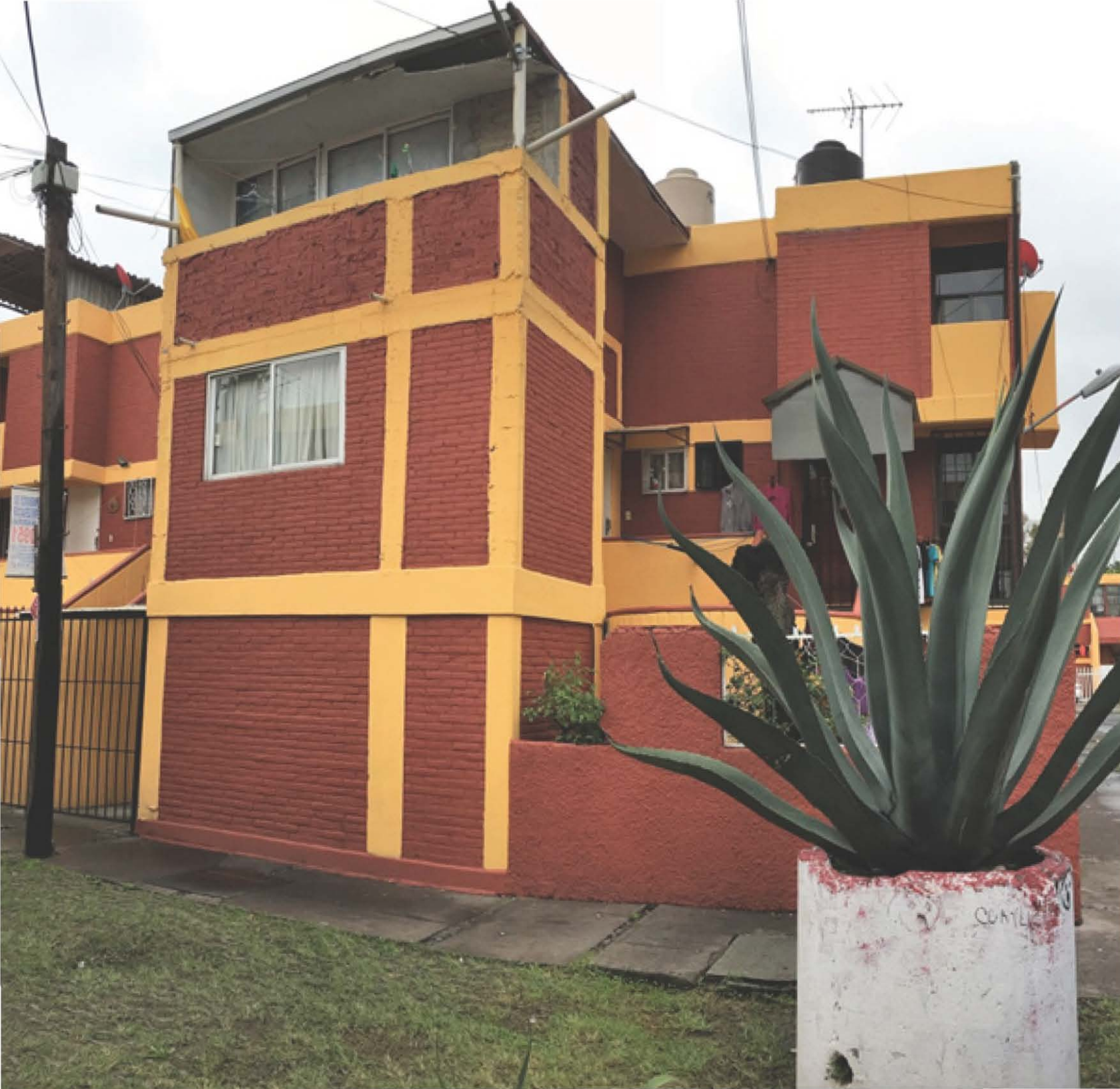
Imagen 3.41. Vivienda con modificación por construcción ubicada en el Bloque 13. Fuente: propia 2017
