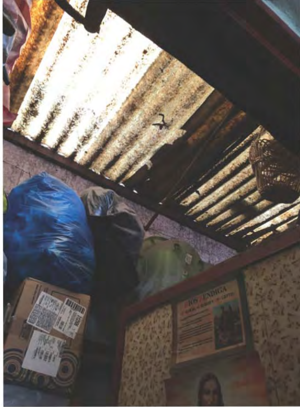
Imagen 4.32. Fotografía del patio de servicio donde se aprecia el domo mediante el cual esta techado.
