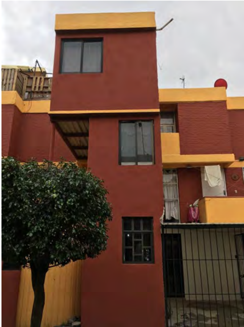
Imagen 3.46. Fachada principal de la vivienda modificada por construcción, ubicada en el Bloque 13 Fuente: propia 2017
