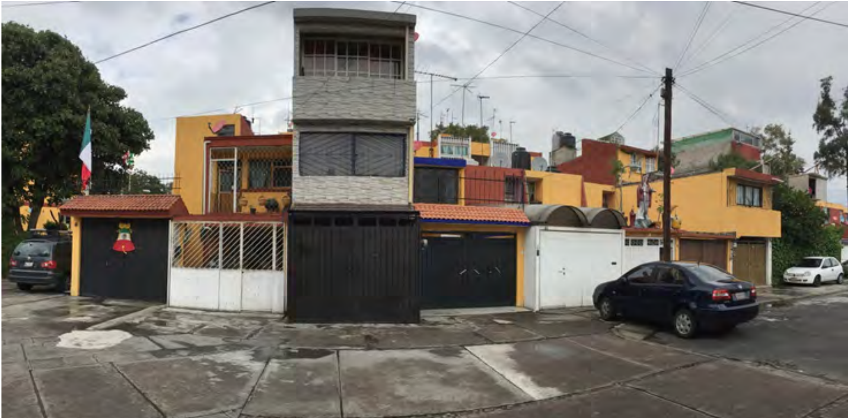
Imagen 1.36. Viviendas Unifamiliares de la sección Piloto con modificaciones por construcción. Fuente: Propia 2017
