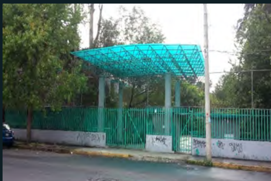
Imagen 1.12. Escuela de Bachilleres No. 4. Fuente: Levantamientos del Laboratorio de Vivienda 2014
