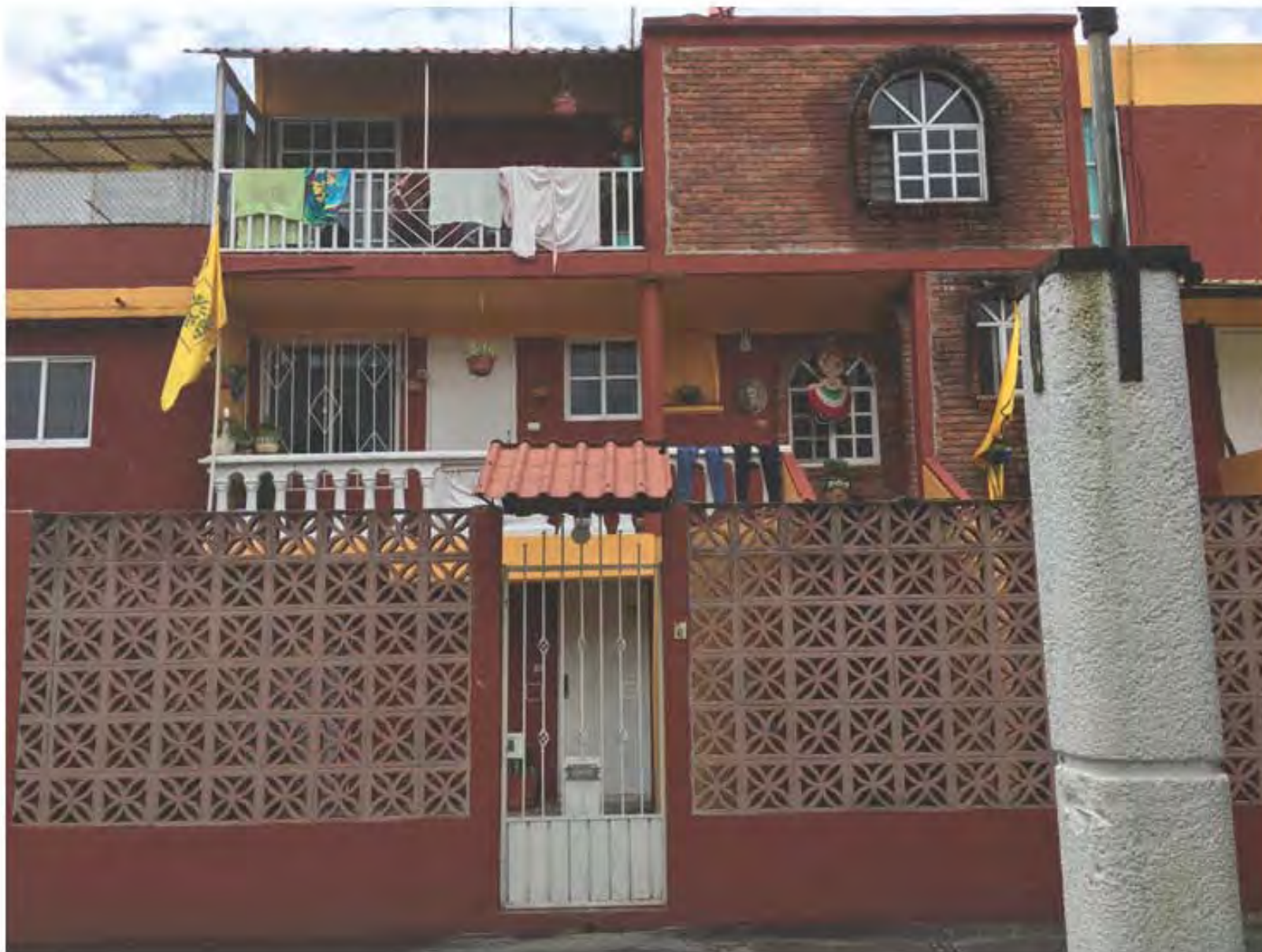
Imagen 3.53. Fachada actual de uno de los edificios de Tipo D ubicada en el Bloque 2. Fuente: propia 2017
