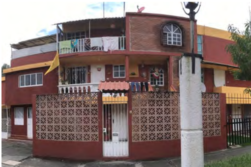
Imagen 3.51. Vivienda ubicada en el Bloque 2 en donde con una flecha se indica el nuevo acceso a una de las viviendas producto de las modificaciones que le hicieron. Fuente: propia 2017
