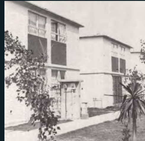
Imagen 1.5. Fotografía de los edificios originales de vivienda de la unidad habitacional CTM Culhuacán. Fuente: INFONAVIT XV AÑOS, 1987
