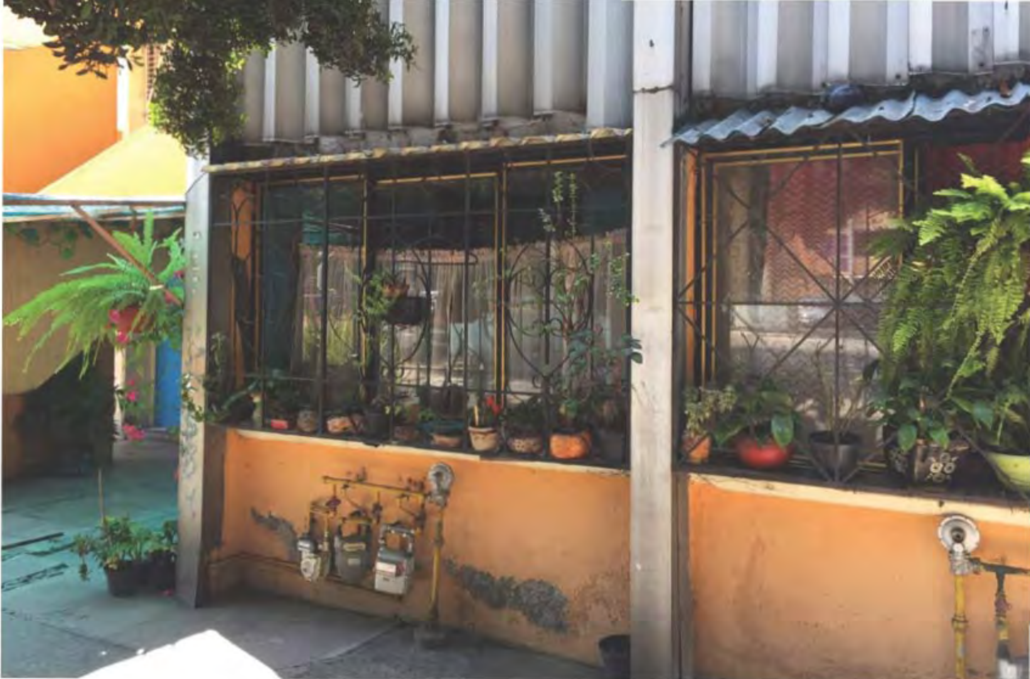
Imagen 4.15. Fachada principal de la vivienda. Fotografía de la ventana que añadieron al quitar la celosía del patio de servicio Fuente: Propia 2017
